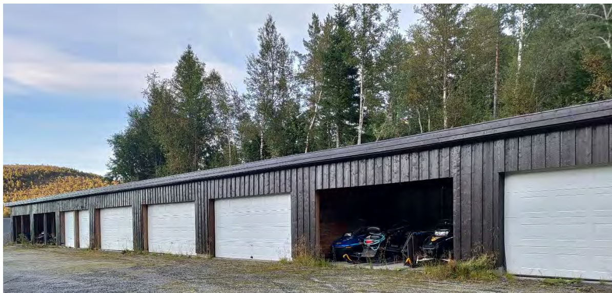
Figur 5-2 Skutergarsje langs Fessdalsveien, ved «inngangen» til Fessdalen. Blir brukt for transport til og fra hytter.
