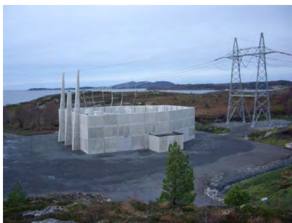
Figur 3: Eksempel på betongsikret muffeanlegg.
