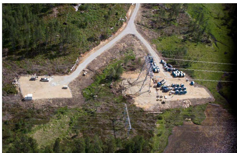
Figur 7: Eksempel på arealbehov for trommeplass/anleggsplass
