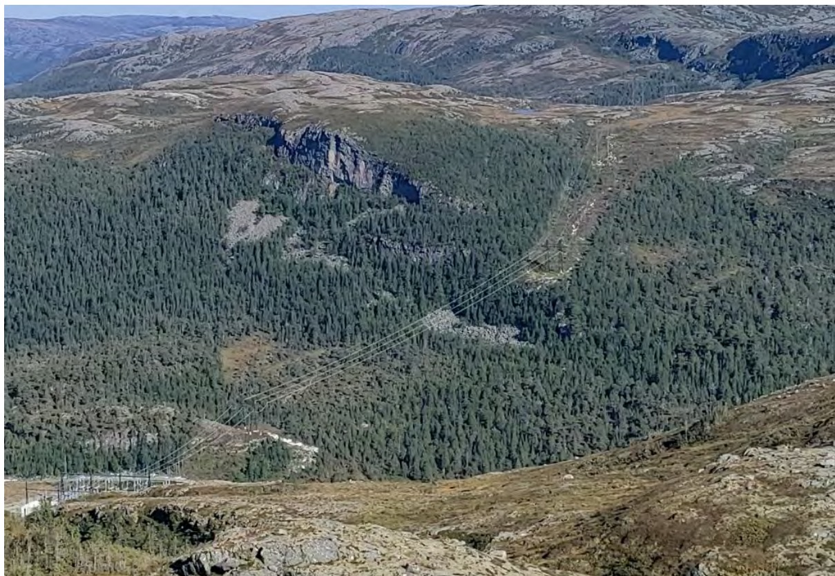
Figur 5-8 Dagens 420 kV-ledning fra Åfjord stasjon og nordover. Sett fra Storheia. Under befaring kunne man se at det fortsatt var «arr» i terrenget etter feltkjøretøy enkelte steder i ledningstraseen til eksisterende 420 kV-ledning.
