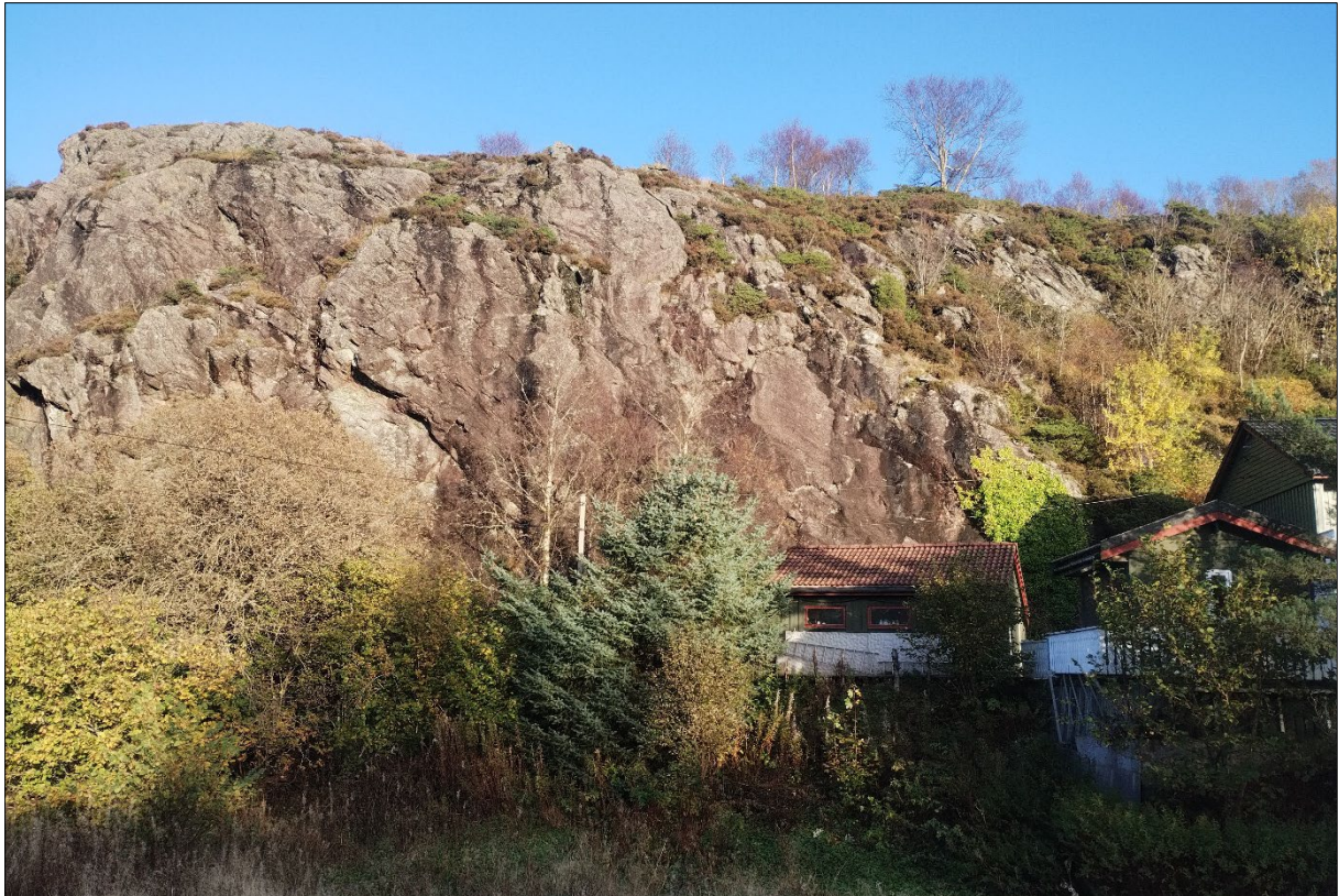
Figur 29: Bilete viser hammarpartiet ved infopunkt 3. Sørleg del av hammaren er vurdert som massiv, men sprekkdanninga aukar noko mot nord (mot infopunkt 2, Figur 30).
