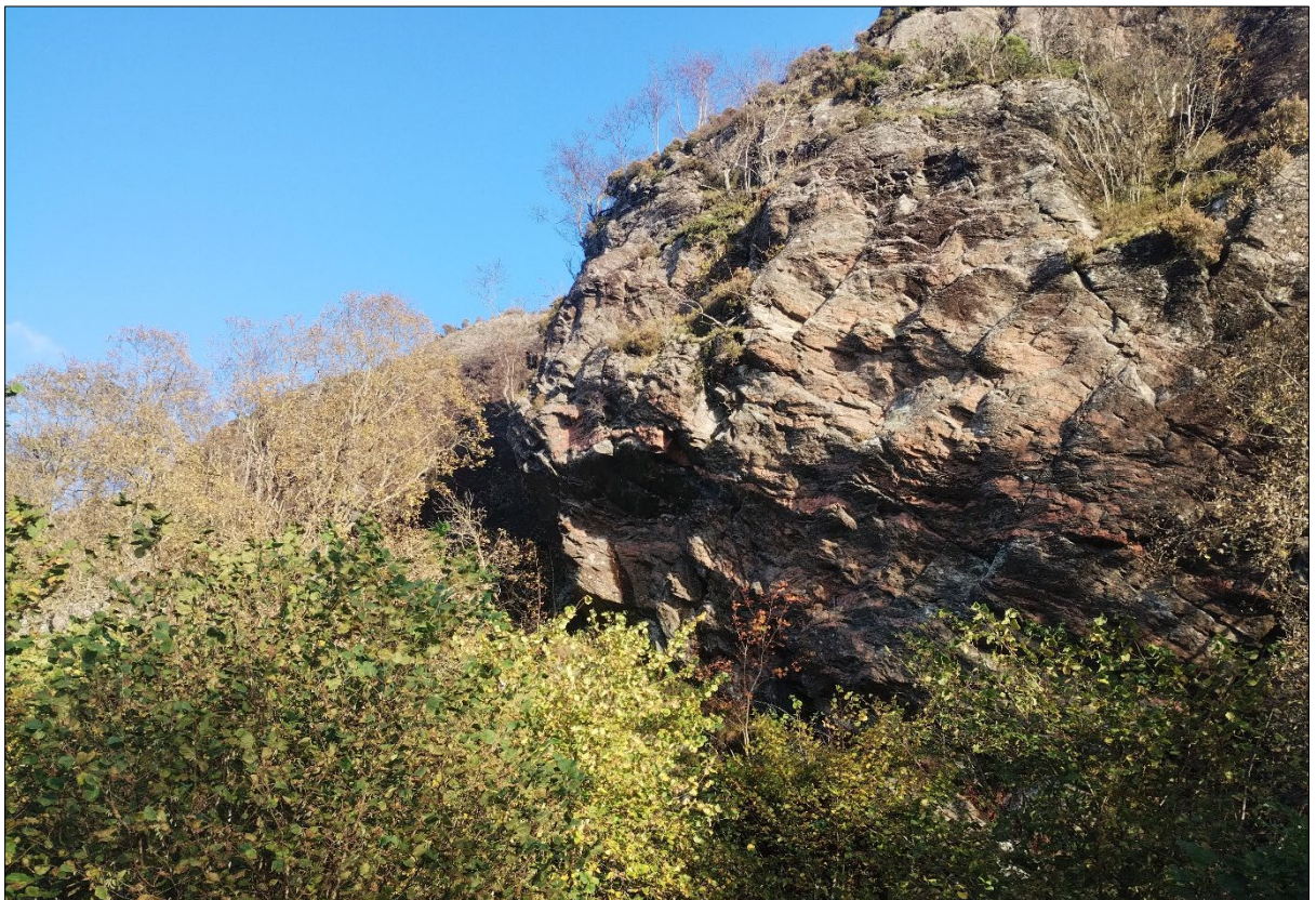
Figur 30: Utsikkande fjellparti med relativt høg oppsprekking ved infopunkt 2.
