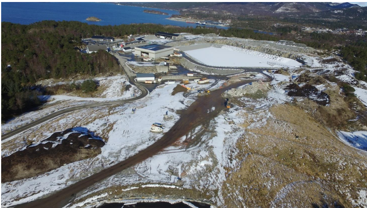
Figur 5-1: Dronefoto over planområdet på HIM. Planlagt kabeltrase for nettilknytning vil gå i opparbeidede arealer med fyllmasser, og vil således ikke være i konflikt med naturmangfold.
