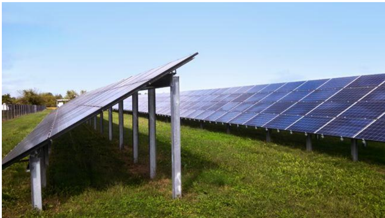
Figur 2-1: Fast-vinkel installasjonsløsning (foto: Willowbrook Solar).
