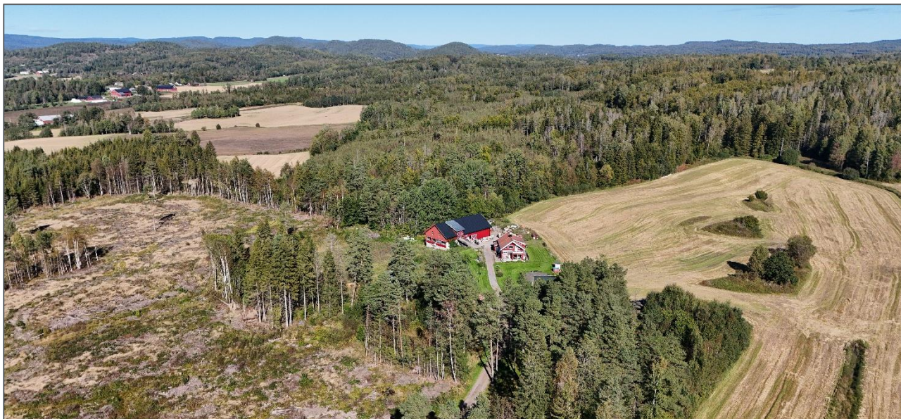
Figur 5-19: Dagens situasjon av planområdet for solkraftverket sett fra sør. Bildet er tatt med drone.
