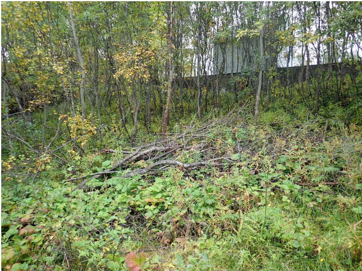
Figur 12. Dam sett mot ventilhus fra nedstrøms.
