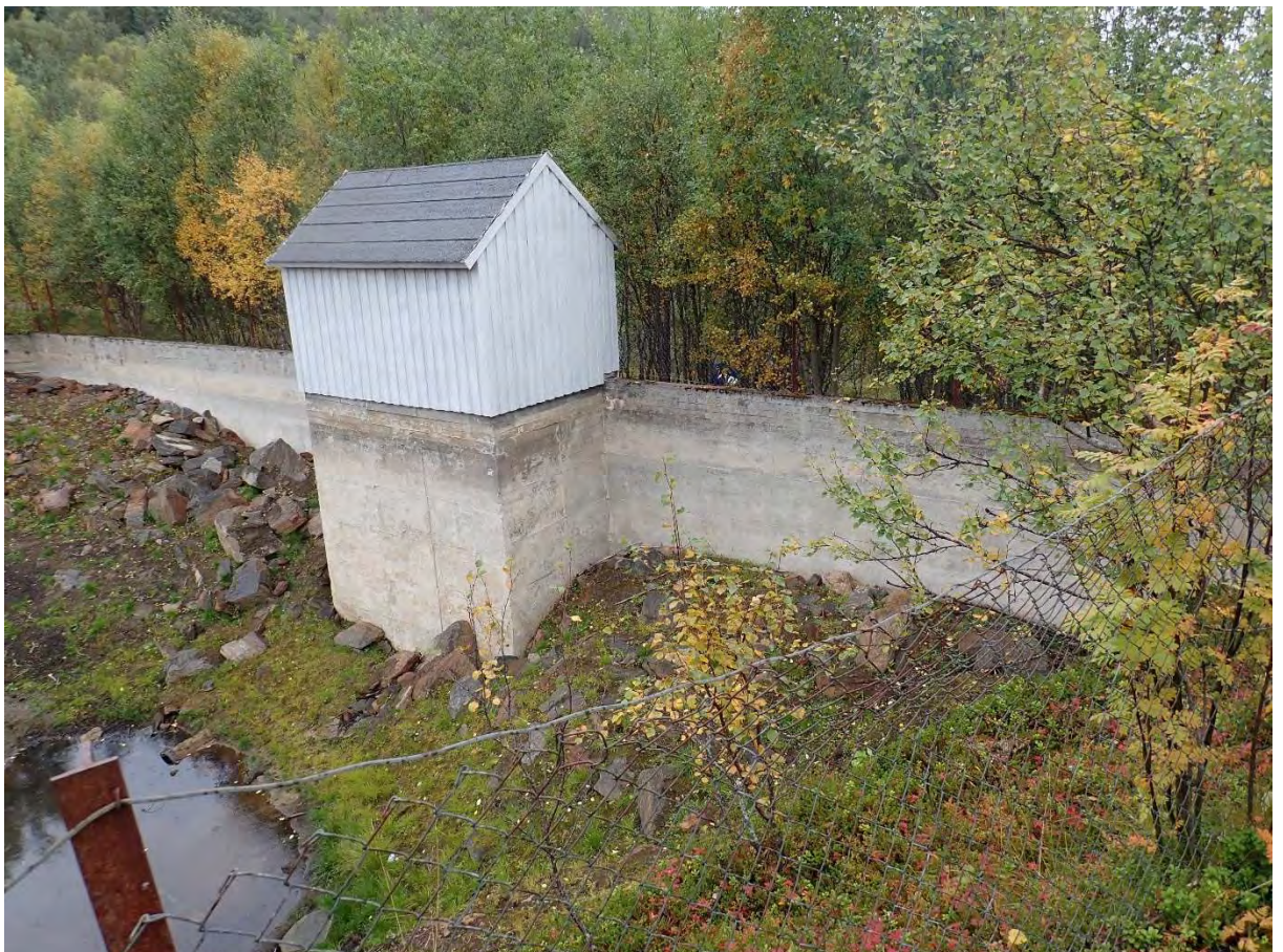
Figur 16. Ventilhus og betong tetting sett fra oppstrøm.
