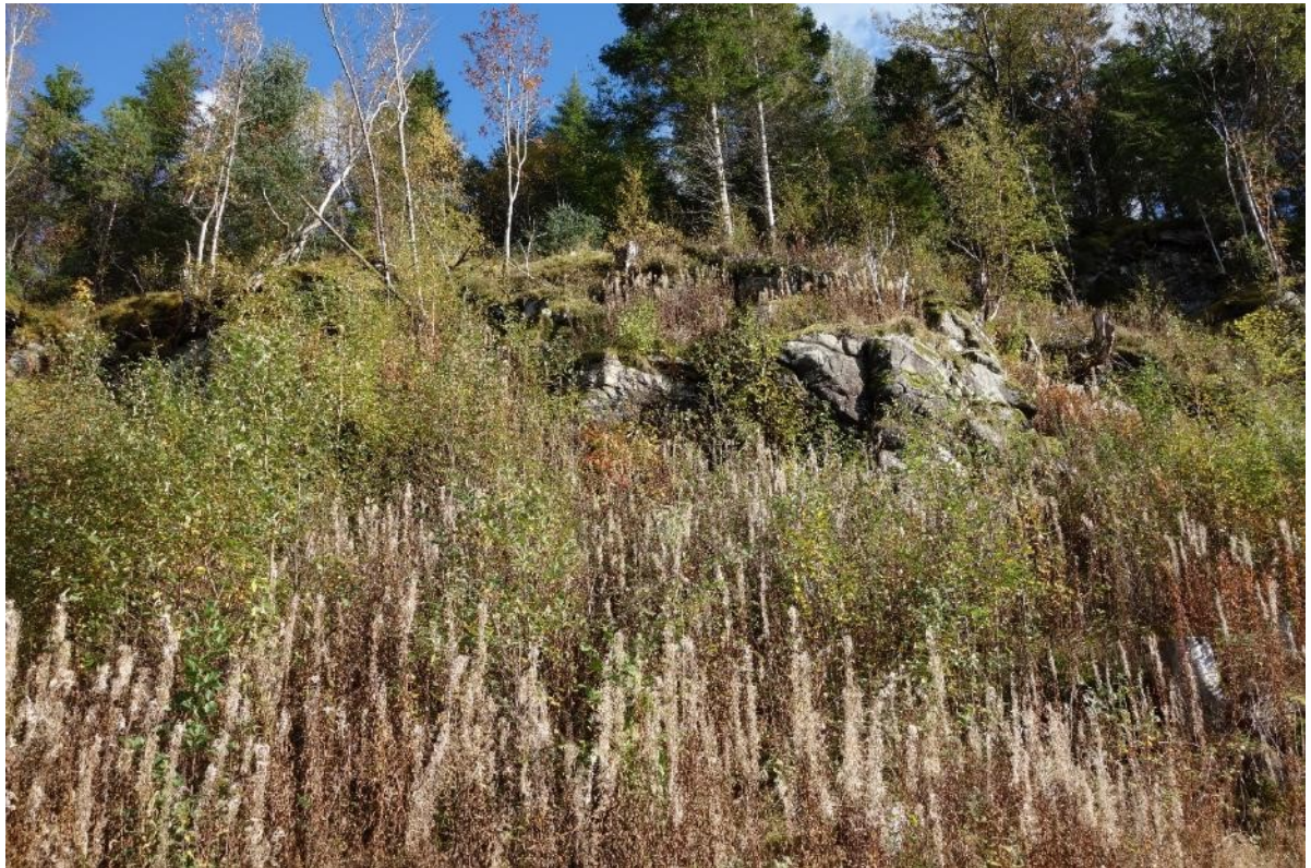
Figur 19. Bergskrent over veiskjæring i område 4.
