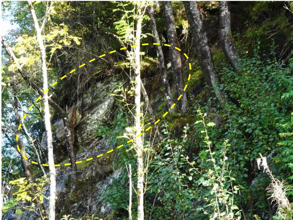
Figur 10. Løs blokk i øvre del av bergskrent 5 meter øst fra eksisterende naust.
