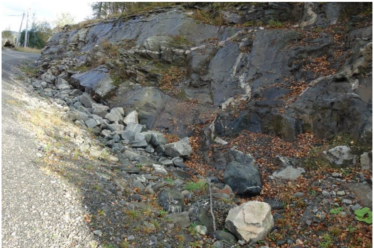
Figur 20. Grøft langs anleggsvei.
