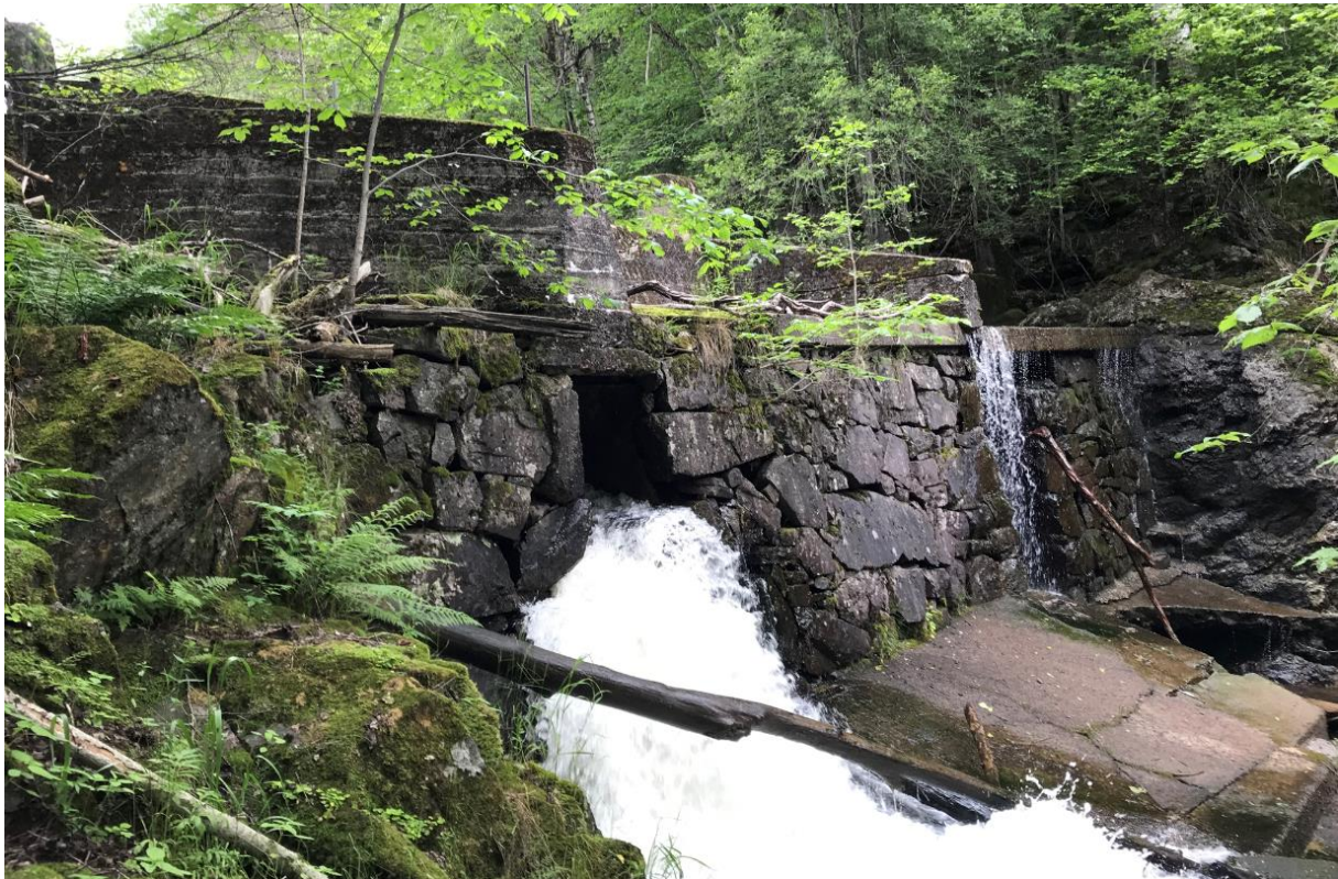
Bilde 2: Bjørumdammen sett fra nedstrøms side. Betong pigges og fjernes. Steinmuren plukkes ned og gjenbrukes i plastring. Bilde datert 20.06.2019.
