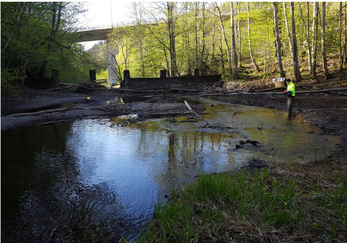
Bilde 10: Magasinet sett fra "halvøy" retning nedstrøms. Nytt elveløp vil gå til venstre i bildet (på østsiden). Bilde datert 18.05.2020.
