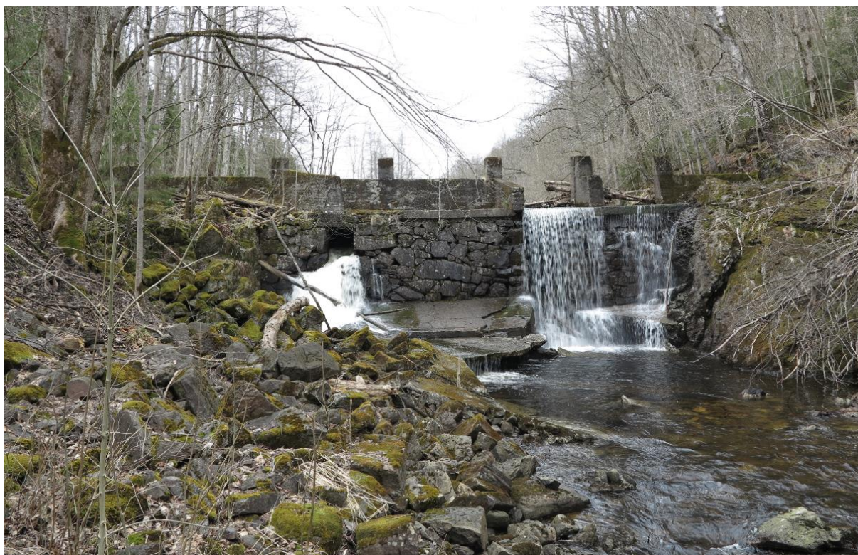
Bilde 3: Bilde av dam fra nedstrøms side. Bilde datert 14.04.2020.
