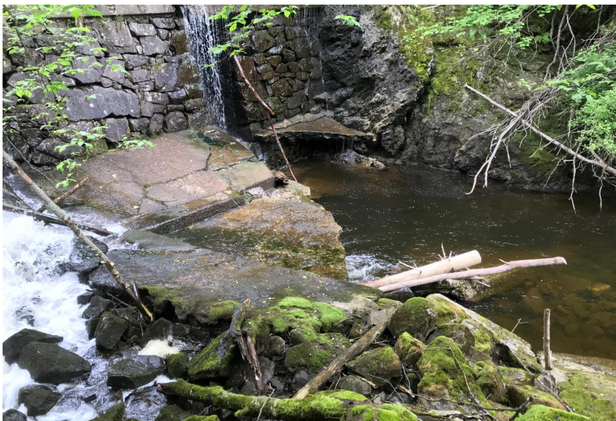
Bilde 4: Bilde av damfot. Betongdeler fjernes. Bilde datert 20.06.2019
