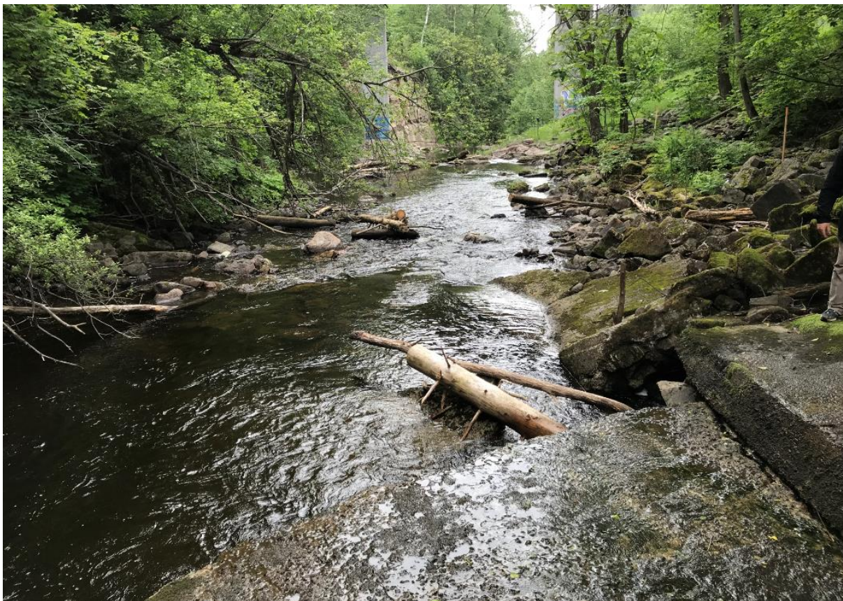
Bilde 5: Bilde mot nedstrøms side, sett fra damfoten. Bilde datert 20.06.2019.
