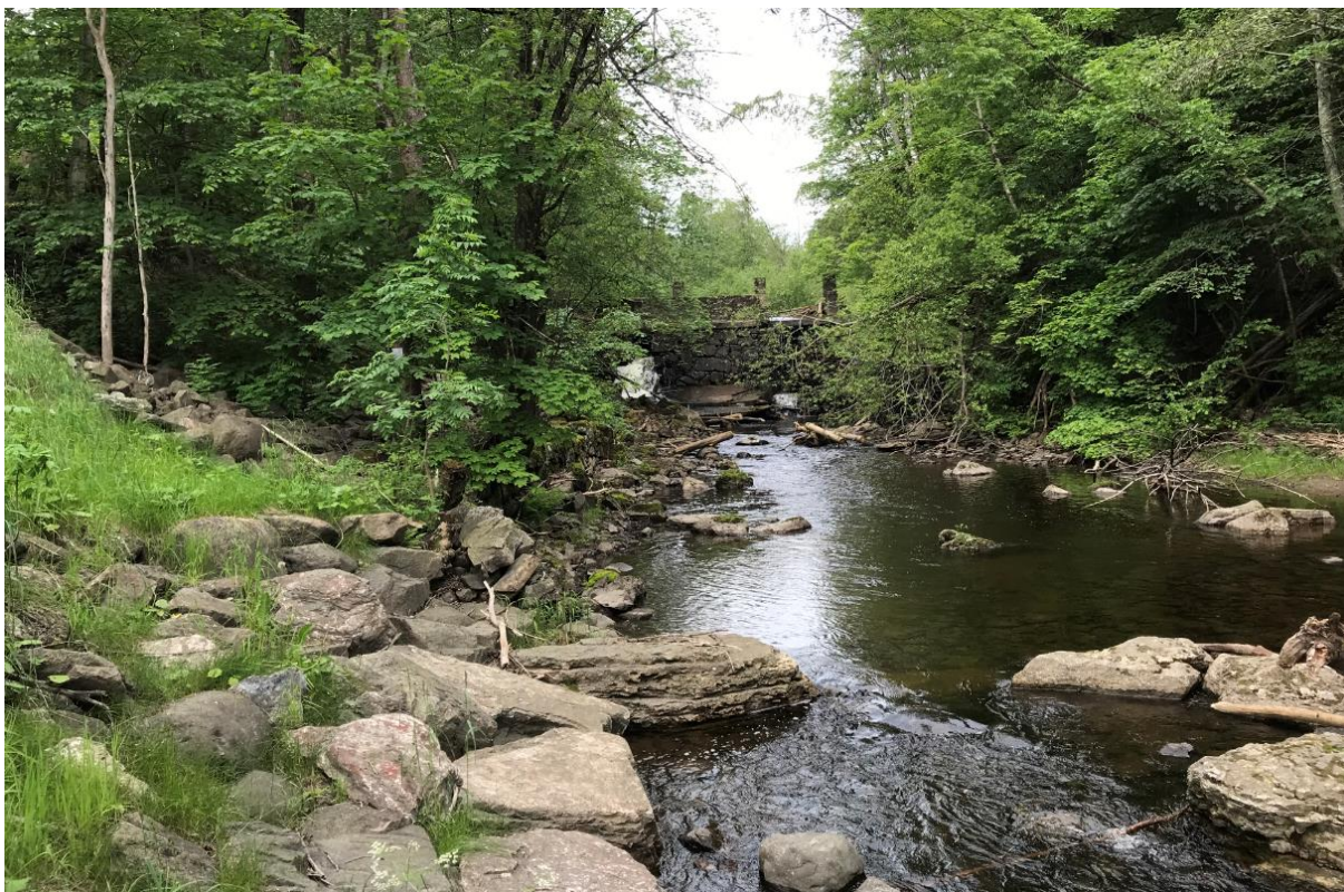
Bilde 6: Elv nedstrøms dam med bilde tatt mot dammen. Bilde datert 20.06.2019.
