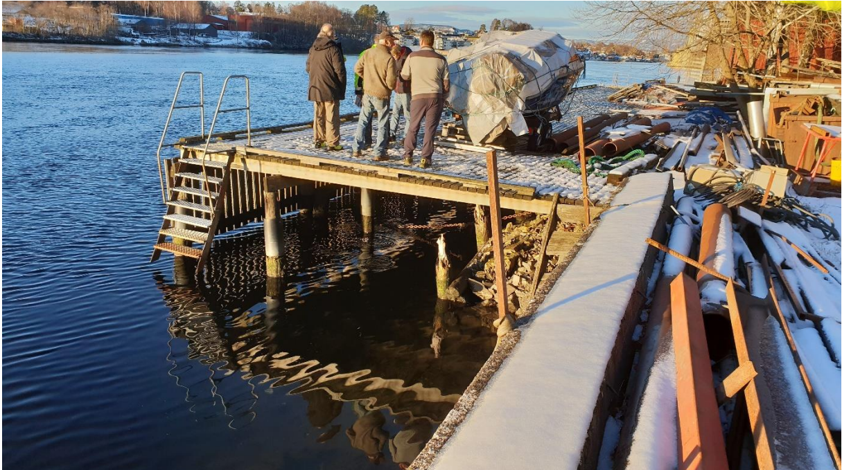
Fig. 2.4 Brygge hvor dekket må demonteres for utlegging av stein opp til kote -2,5. Foto Martin N Jespersen, NVE
