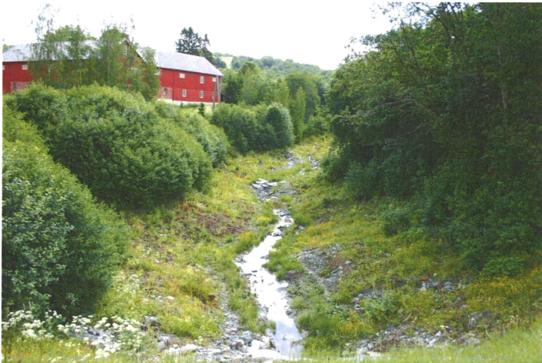
Bildet viser miljøtilpasset steinfylling. Valsetbekken i Skaun kommune 1 år etter lagt fylling
