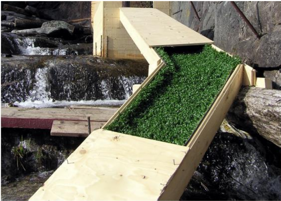
Figur 9. Eksempel på til utforming av ålerenne, denne kan være åpen eller med lokk, fra Calles mfl. (2013)
