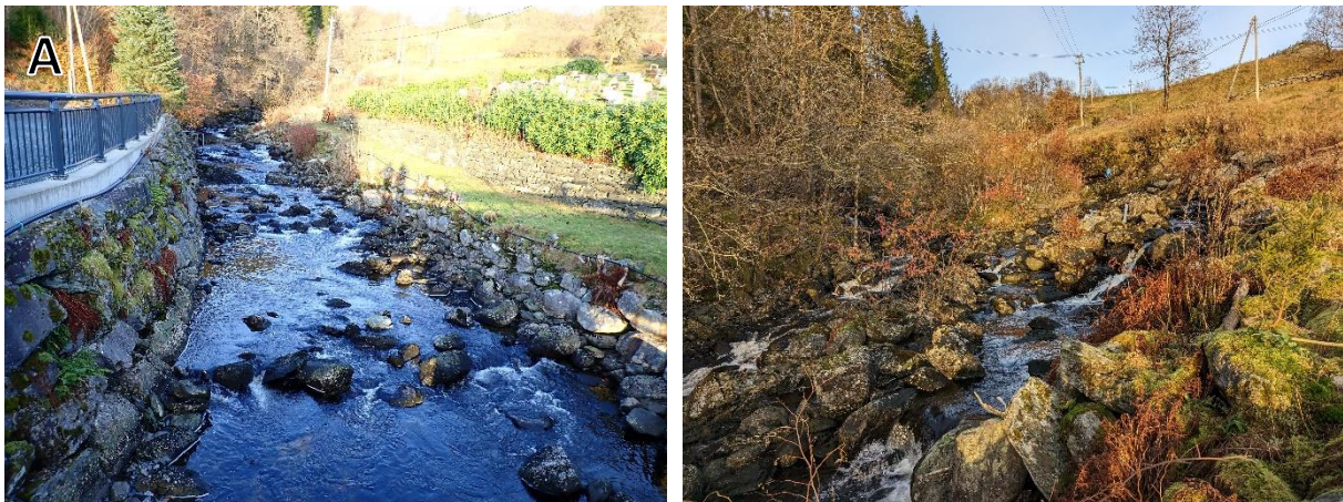
Figur 3. Morfologiske inngrep i Onarheimselva: A) Flomsikring og manglende kantvegetasjon i segment 2. B) Gammel tilbaketrasket forbygning og manglende kantvegetasjon i segment 3 og 4.
