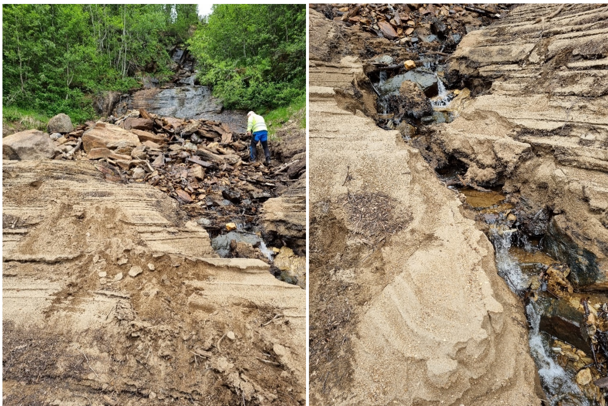
Figur 2. Erosjon i delta etter senking av magasinet.
