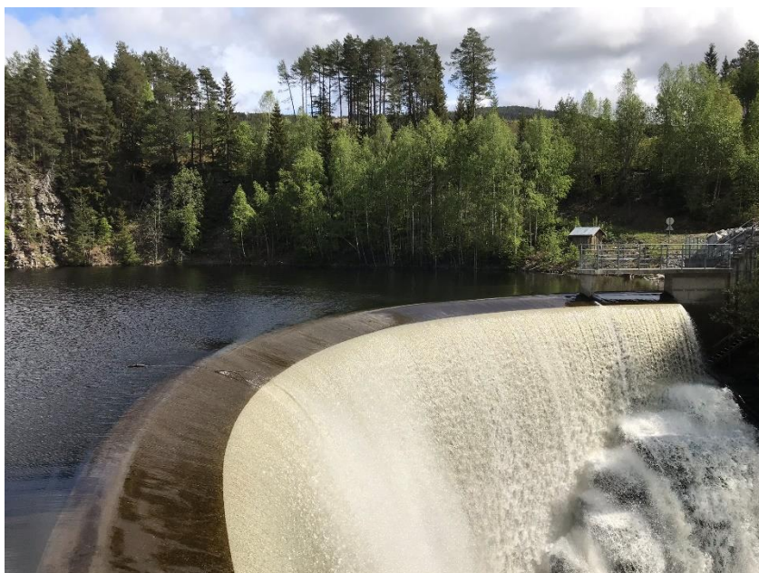
Figur 2-7 Vinkelfallet dam ved overløp.
