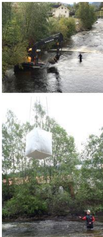
Figur 4-2 Utlegging av grus ble gjort både med gravemaskin og mobilkran/storsekk.
