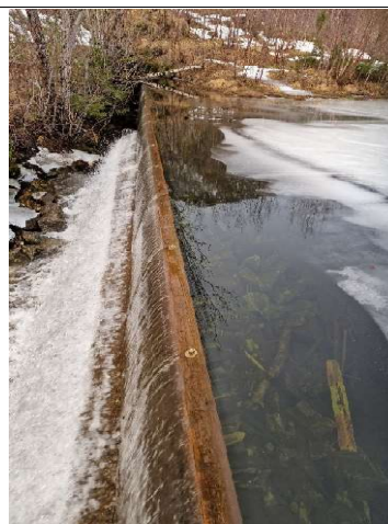
Bilde 3-2 , viser bjelkestengselet sett ovenfra
