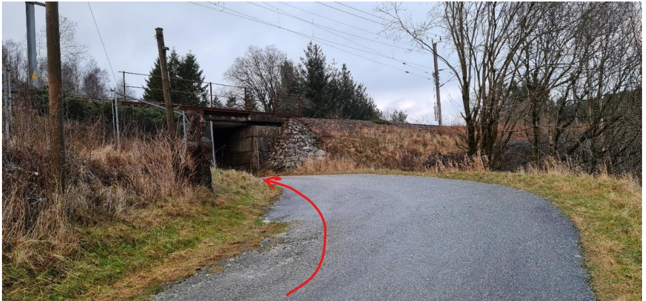
Foto 3. Bilde av undergang. Pilen viser retning fra Svanevann trafostasjon mot kabelendemast.
