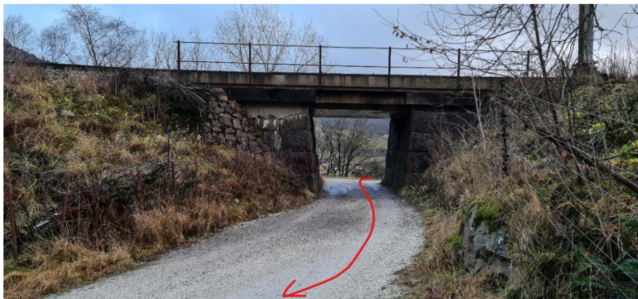
Foto 2. Bilde av undergang. Pilen viser retning fra Svanevann trafostasjon mot kabelendemast.
