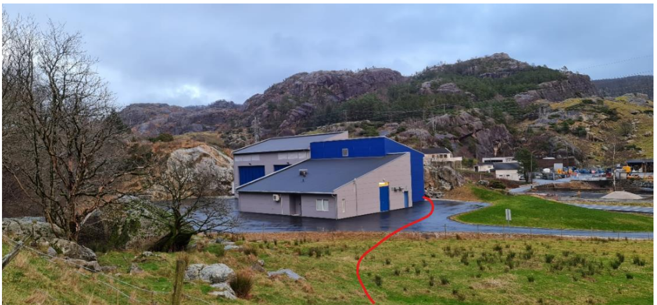
Foto 4. Bilde av Svanevann trafostasjon.
