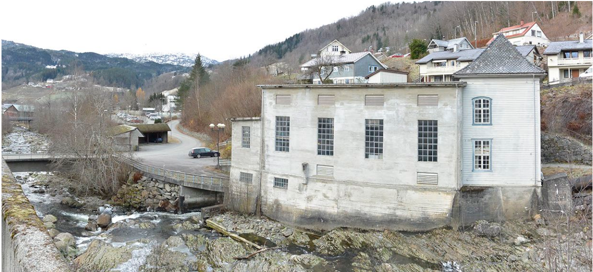
Figur 7 Etter utviding på 50-talet står den øvre delen igjen som den einaste originale, med trekledning. Ny bygningsmasse har eit meir funksjonalistisk preg og er utført i betong. Hovuddelen er vorten både breiare og lengre, slik at kraftstasjonen har sprang i sideretning og beslaglegg større del av elveleiet. Elveleiet har lite kantvegetasjon.
