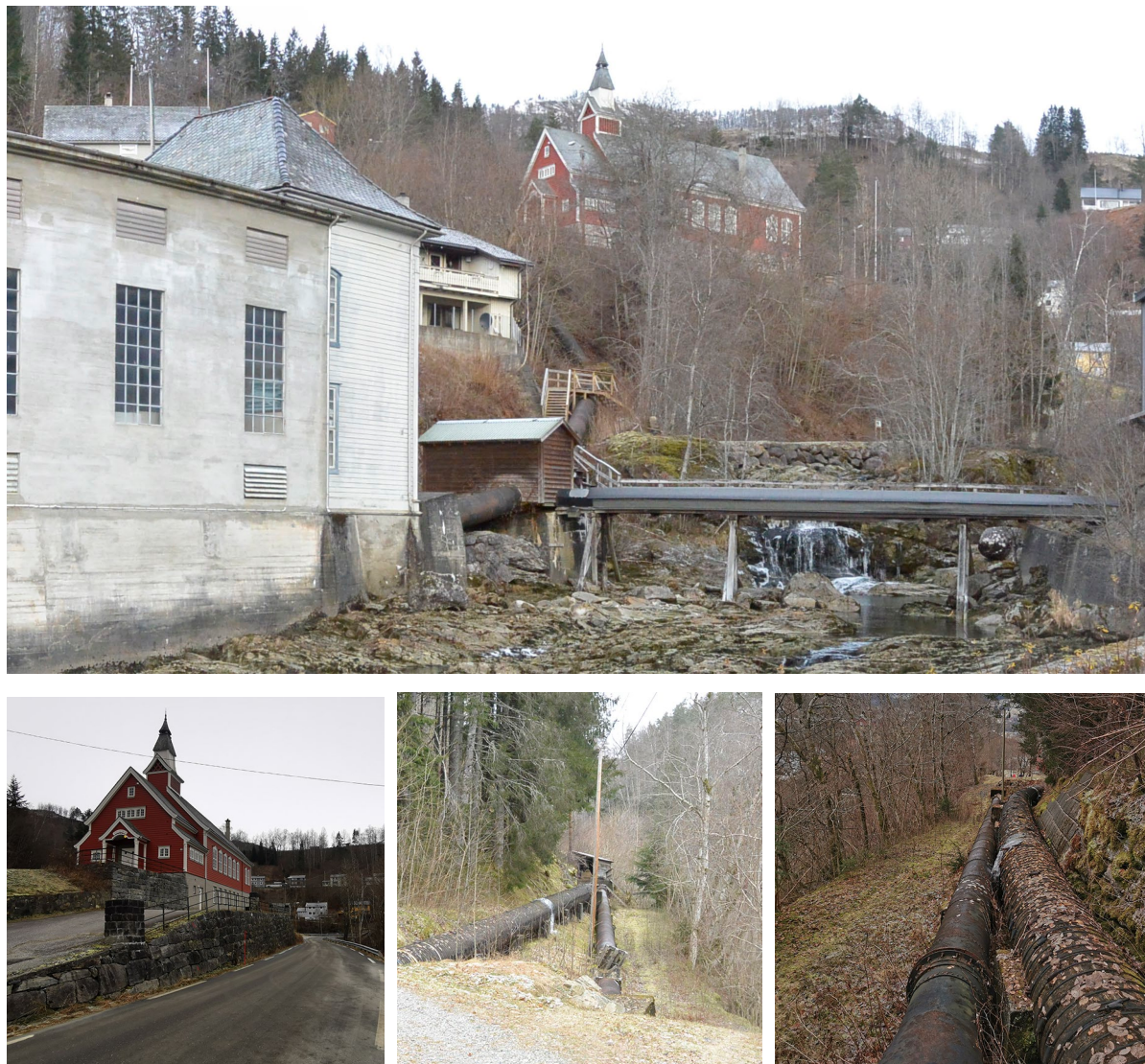
Figur 11 syner røyrsgata ut frå kraftstasjonen øvst, der ei bru er etablert over røyrsgata for kontinuitet i gangvegssystemet. Under vises ungdomshuset med dei fine tørrsteinmurane, der røyrsgata ligg nedunder desse. Ved sida av vises den siste delen av røyrsgata, nedanfrå i midten og ovanfrå til høgre, der ungdomshuset så vidt kan skimtast i forlenginga av den synlege røyrsgata.
