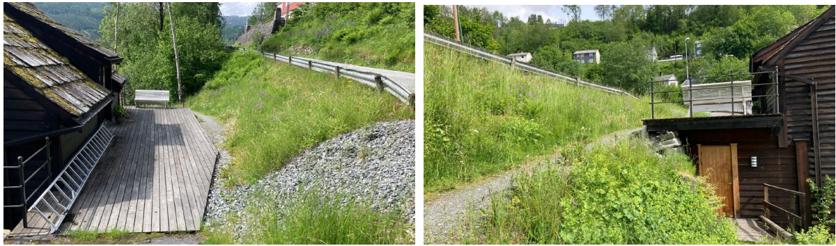
Figur 13 Bratt skråning frå vegen mot Skeie-mylna til venstre og underliggende konstruksjon til høgre.
