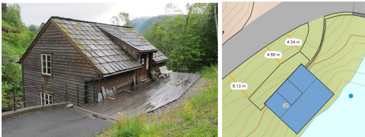
Figur 12 Åtkomst med stor transport og tunge køyretøy lyt skje via gangtrase forbi Skeie-Mylna. Profilet forbi bygningen er trangt og traseen går i dag over eit dekke som og tener som overbygg for gamle, underliggende konstruksjonar, tilhøyrande mølla. Figuren til høgde syner at breidda på skråninga mellom dekke og fylkesvegen varierar mellom 4,5 og 6 meter, der hellinga jamt over er 1:2.
