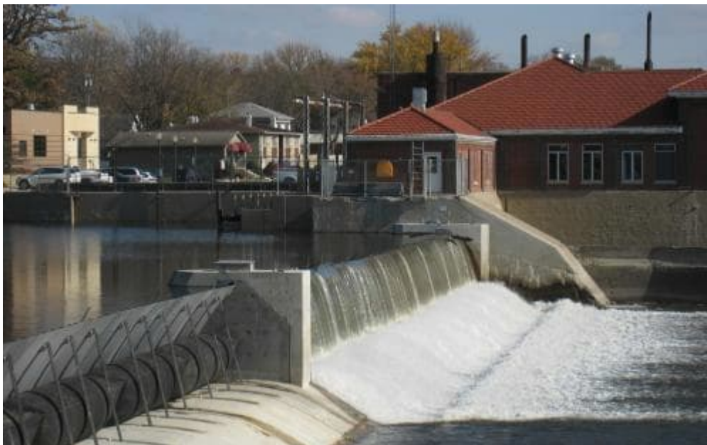
Figur 12 Eksempel på Obermeyerluke.
