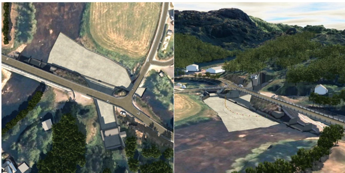
Figur 9 Visualisering av tunnelinntak med luke og plassering av luker i elva uten vann.
