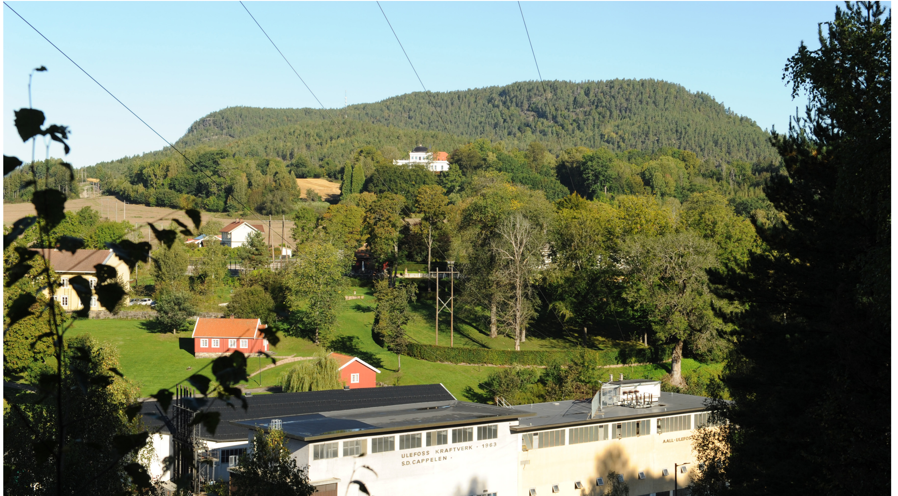
Figur 8. Bildet viser dagens situasjon ved Ulefoss kraftverk.
