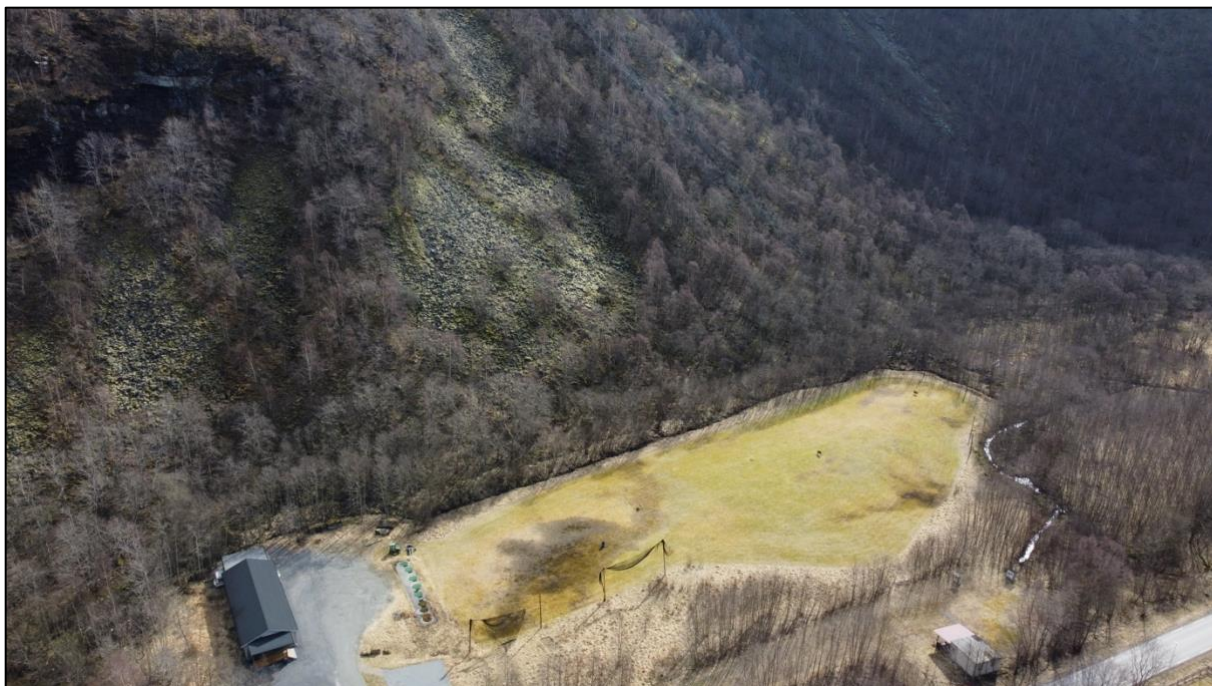
Figur 19: Nedre del av skråningen i øst, sett mot sørøst, med urmasser ned mot dalbunnen.
