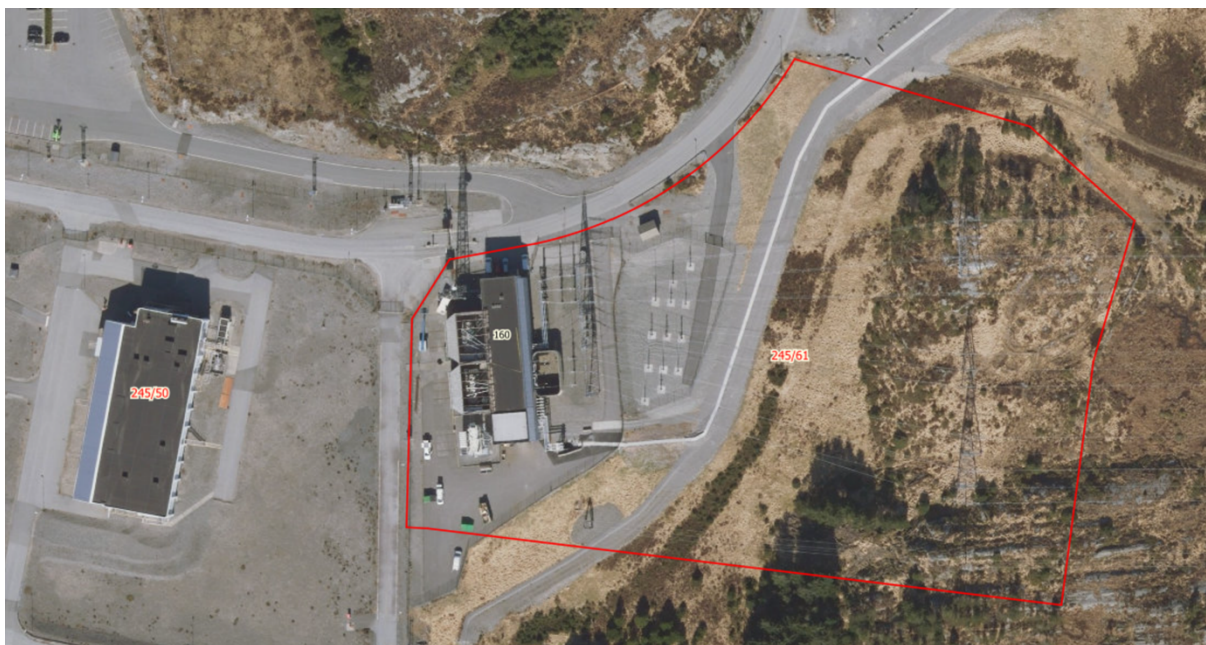
Figur 2 Kollsnes transformatorstasjon med eiendomsgrense midt i bildet. Plassering av ny transformator og reaktiv kompenseringsanlegg er vist på figur 1, side 3. Kilde: NVE Atlas
