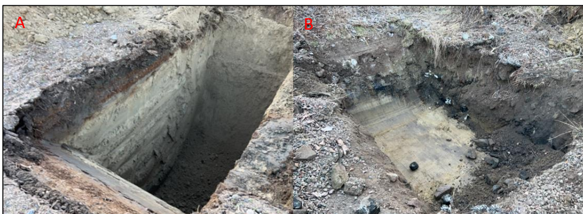
Figur 3. A: Viser bilde av prøvegrøp ved PG1. Organisk overflatelag 0-0,3 m, tydelig overgang til sandige masser synlig ved ca. 0,3 m. B viser PG6 0-1 m, svarte masser synlig ved ca. 0,7 m.
