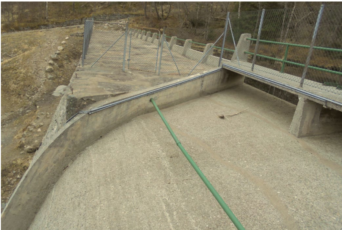
> Figur 1-7 Sekundærflomløp Skredderdalen, foto Thomas Konow
