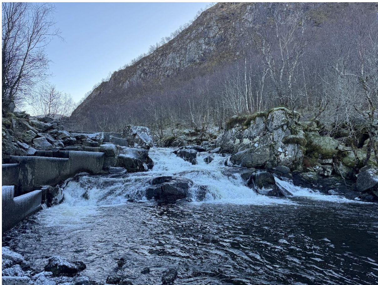
12.02.2025. Vassføring: 1,3 \text{ m}^3/\text{s} (SWECO)
