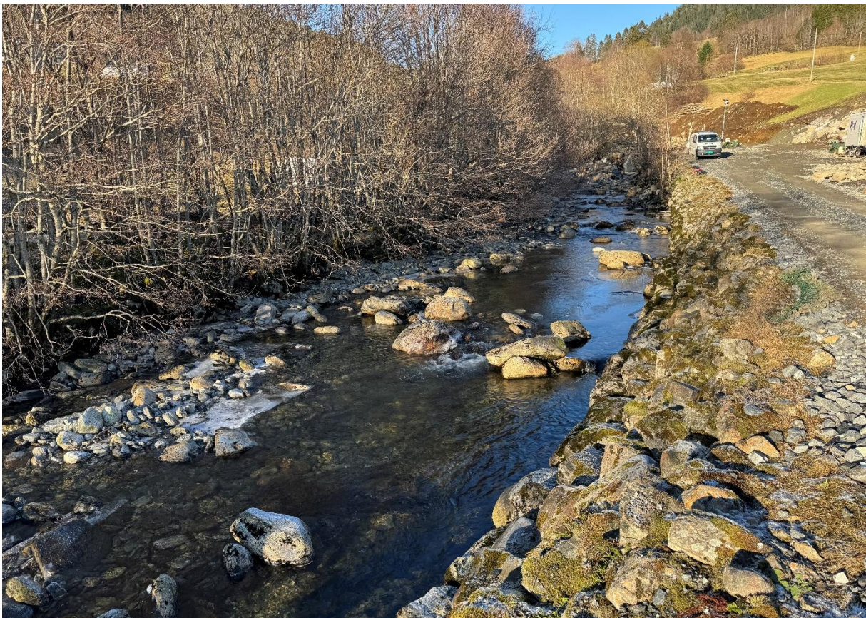
12.02.2025. Vassføring: 100-150 l/s. Arbeid med Stårheim kraftverk er påbegynt.
