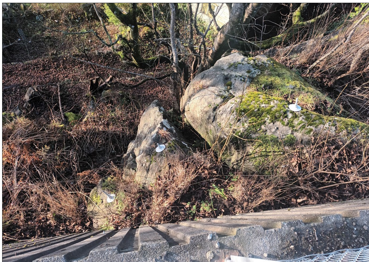
Figur 20: Nordleg del av hammarpartiet i kartlagt område (infopunkt 1) er sikra med boltar i øvre del av hammarpartiet. På toppen av hammarpartiet er det ei betongmur.
