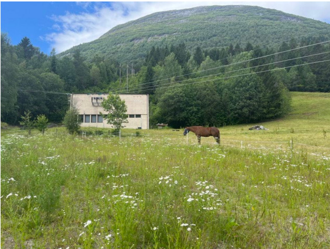
Figur 37 Bø transformatorstasjon ligger helt øst i delområdet. I bakkant sees fjellet Gryta, som ligger i delområde 2.
