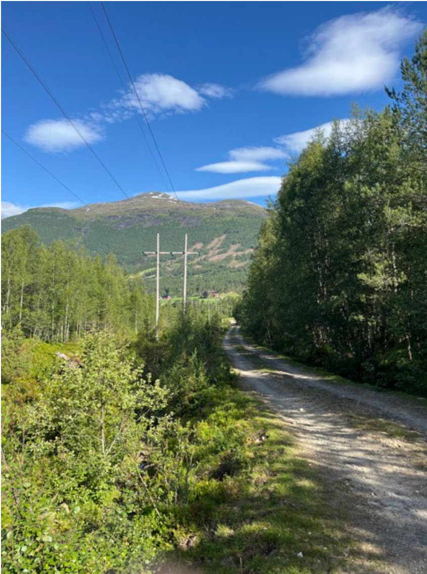
Figur 52 Bilde tatt sør for Tomasgard stasjon i retning nord, langs eksisterende kraftledning som skal oppgraderes. Mastene skal beholdes om mulig.
