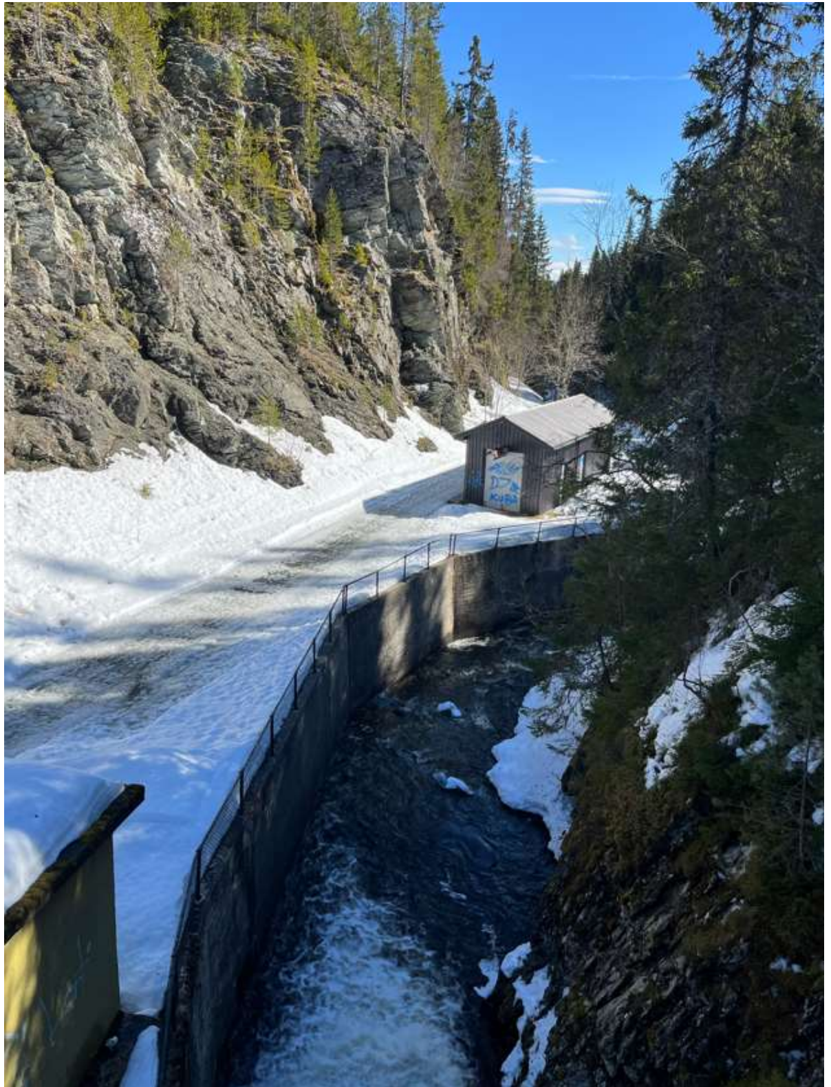
Figur 4-14: Bilde av Leirelva. Tatt fra damkrona på befaring ifm flomberegning av Leirsjødammen.
