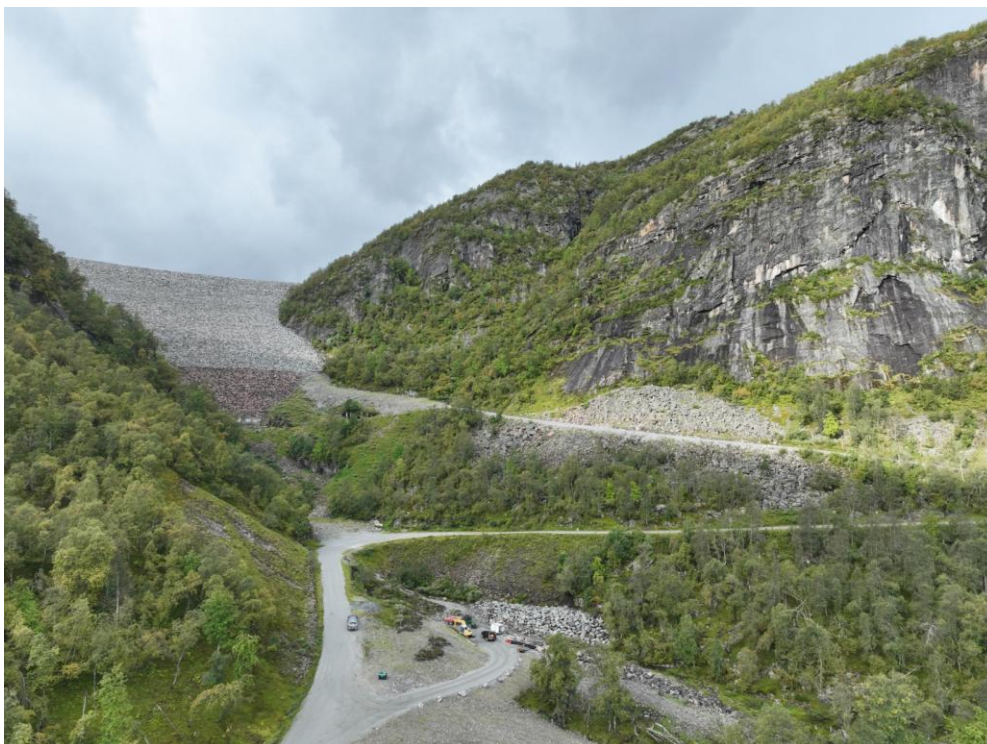
Figur 16: Oversiktsbilde mot dam. Bildet er tatt mot sør.
