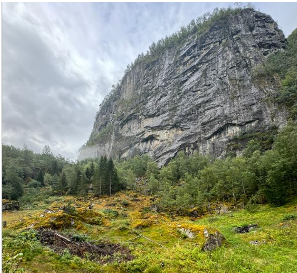
2.4.3 Figur 31: Fjellside over østre ende av deponi 2. Steinsprangfare fra klippen opp til Lauvberg. Her må deponimassene legges på en forsvarlig måte for å danne overhøyde og en barriere mot steinsprang. Behov for sikkerhetssone mellom deponi og fjellside må detaljvurderes, skissert deponiutforming er lagt med en sikkerhetsavstand på 20 meter fra fjellsiden.
