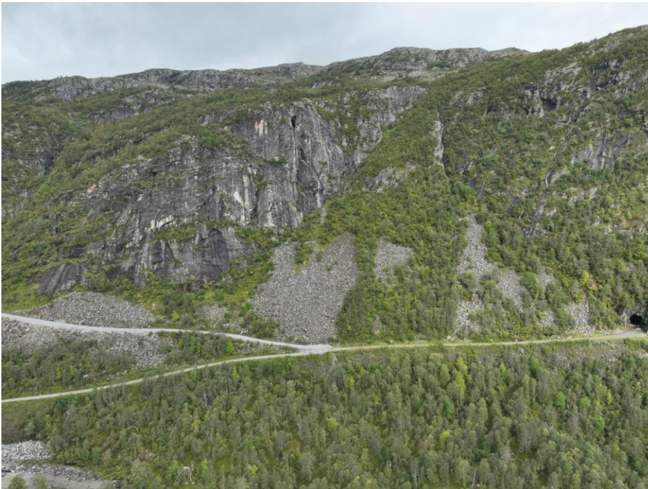
Figur 5: Skråning over adkomstveg til eksisterende og planlagt nytt tverrslag.
