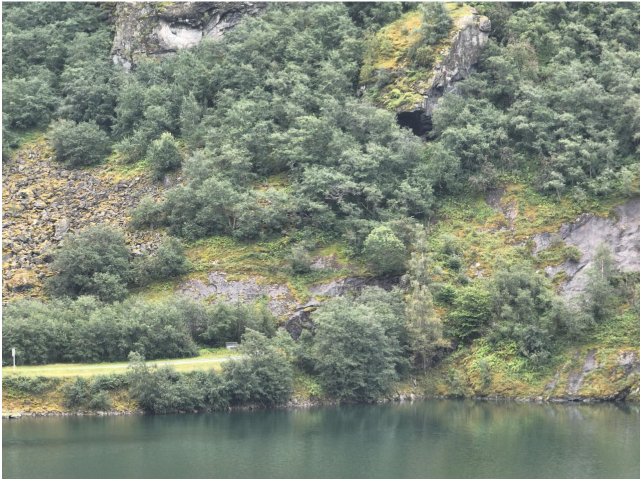
Figur 25: Bilde av skråning rundt eksisterende tunnel. Over tunnel ligger det en stor blokk/berghammer som fungerer som en barriere over dagens påhugg.
