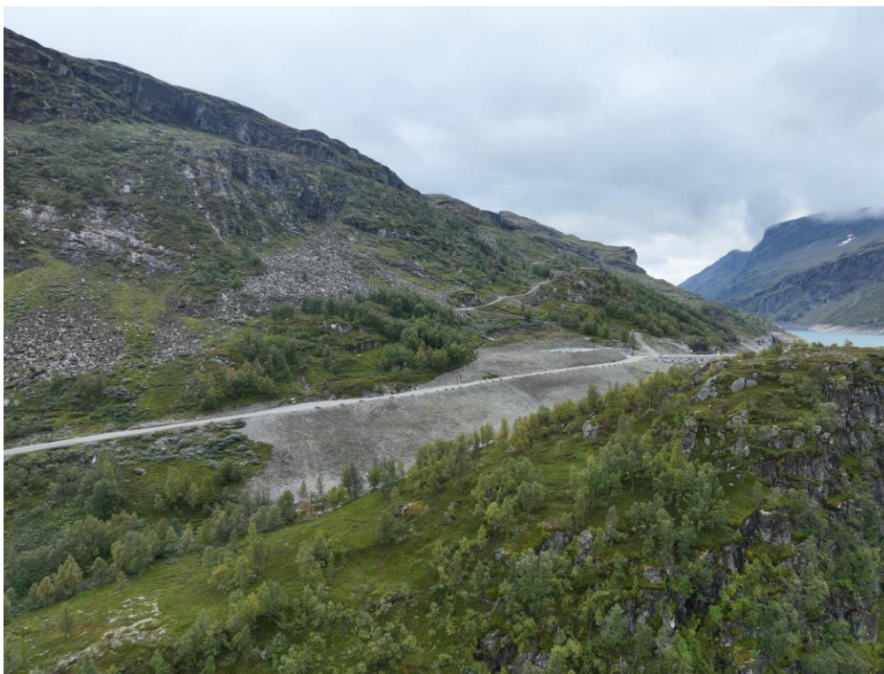
Figur 12: Oversiktsbilde over adkomstvei. Bildet er tatt mot sør-øst.
