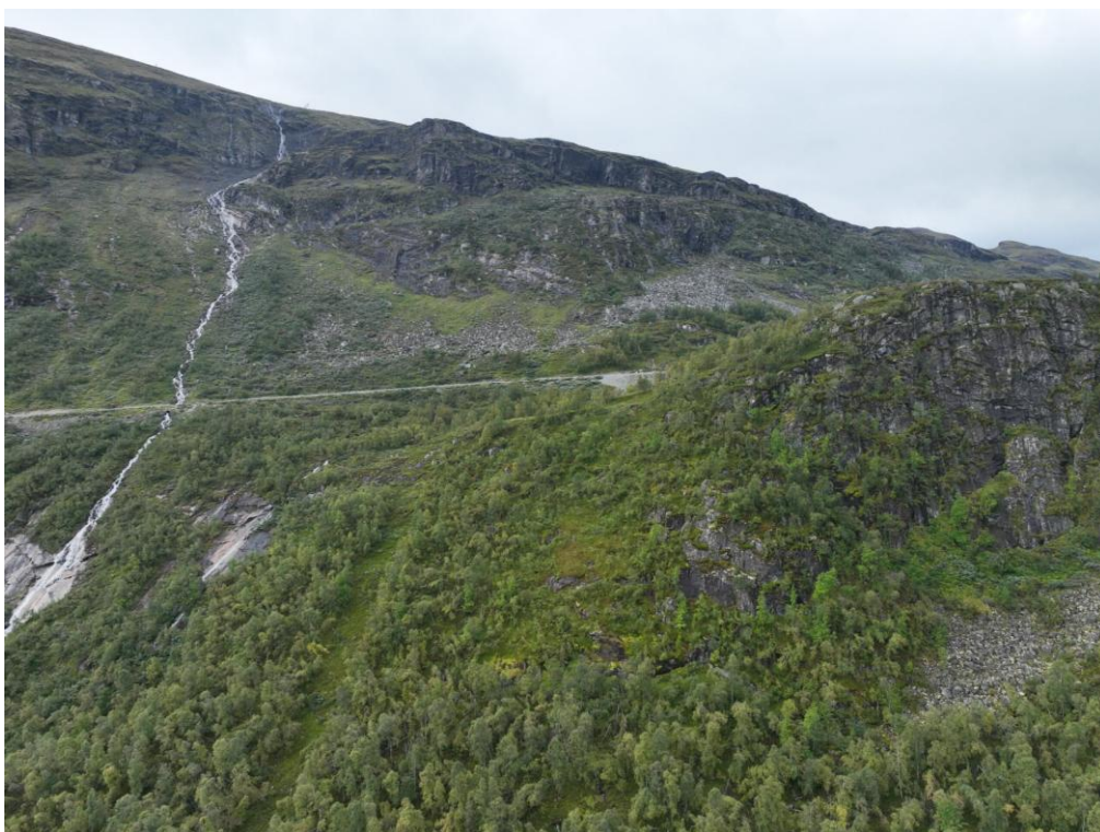
Figur 11: Oversiktsbilde over adkomstvei. Bildet er tatt mot øst.
