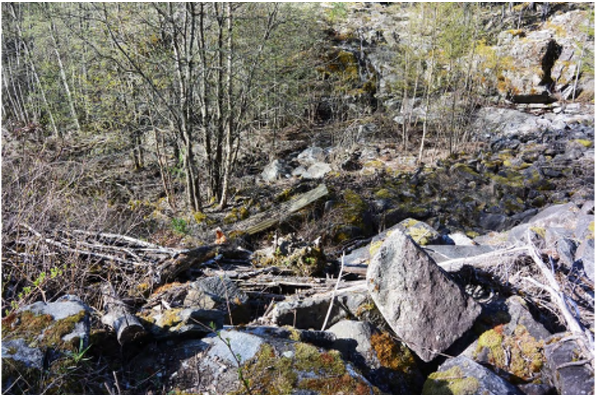
Figur 2-4. Gammelt flomløp i gjengroing og med mye gammel sprengstein.
