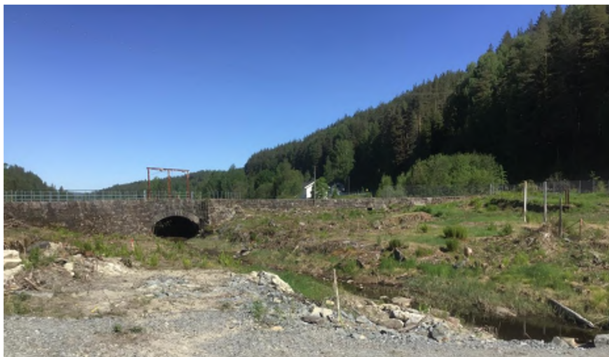
Figur 2-2. Gammelt flomløp nedstrøms eksisterende dam der dagens vegetasjon er fjernet.
