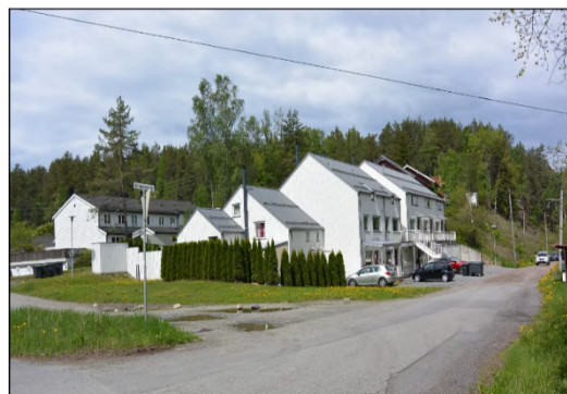
Figur 10: Grønmoveien ved avkjørsel fra Enebakkveien. Bebyggelsen består av Godheim gård, villabebyggelse og rekkehus. Liåsen ses i bakkant. Ny adkomstvei til alternativ B må bygges parallelt med Grønmoveien.
