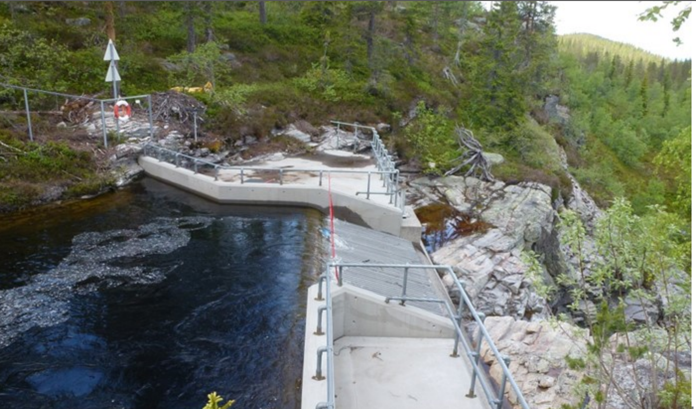
Dato 11.06.2012 Hølseterbekken med høy vannføring
