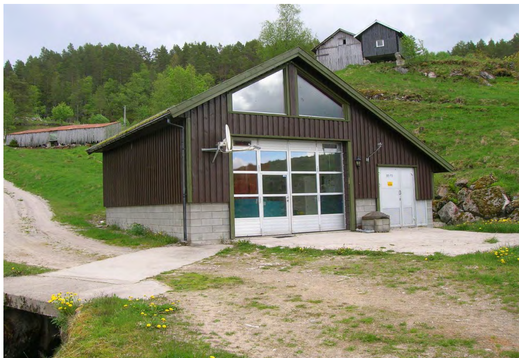
Fig.1: Bergesli kraftverk mai 2022 (Foto: Småkraftkonsult)
