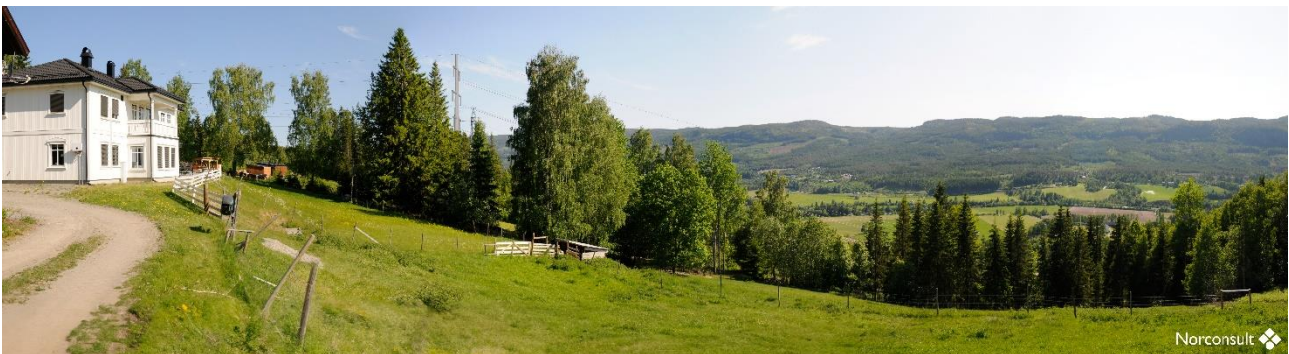
Figur 4-3. I bakgrunn kan dobbeltkursmast sees. I alternativet er det her overgang mellom dobbeltkursmast til parallelle H-master med planoppheng.
