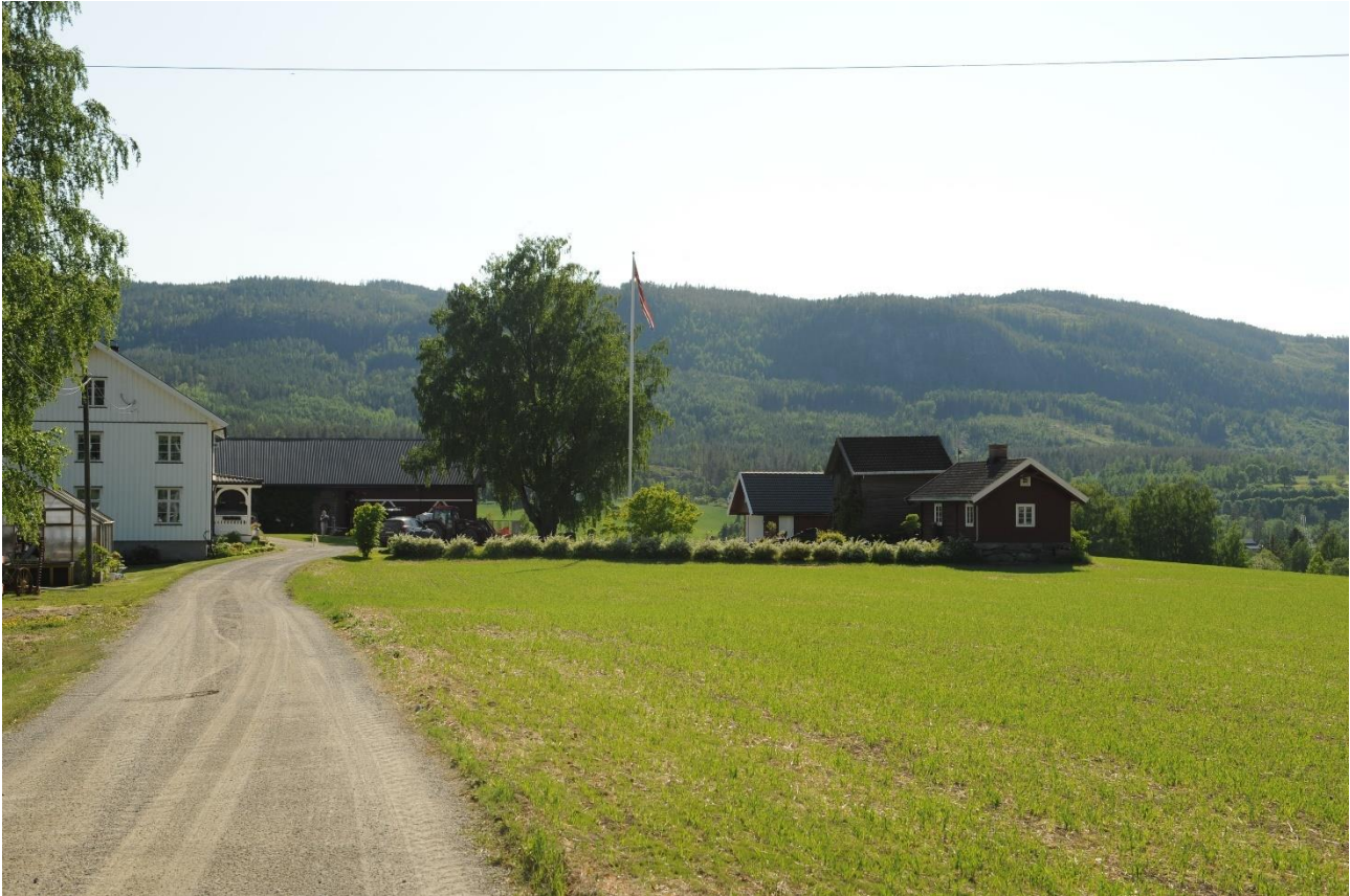
Figur 3-8 Oversikt over tunet på Nordre Aurlund. Hovedbygning skal være fra 1700-tallet ifølge SEFRAK.
