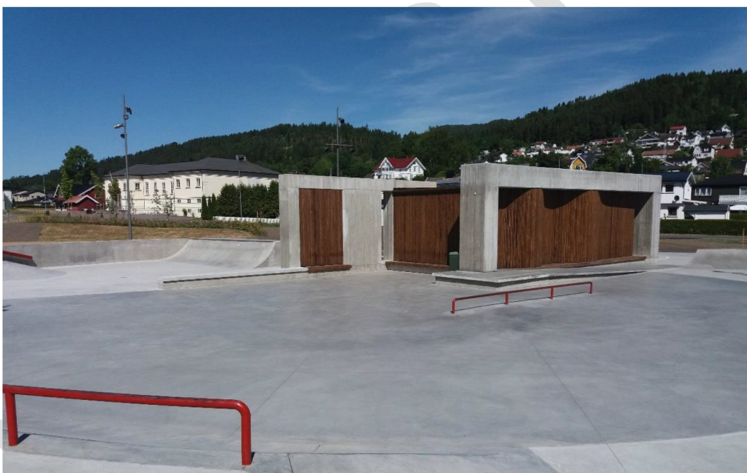
Figur 7-1 Pumpestasjon for overvatn i nedsenka skatepark med sittebenkar og klatrevegg. Krokstadelva i Drammen kommune, NVE / Rune Bratlie
