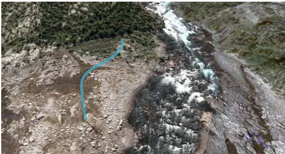
Figur 31: Eksisterende terreng ved utløpskanalen ved lavvannstand i Pålsbuffjorden. Kanalen er lagt slik at den følger eksisterende lavbrekk ut i reguleringssonen i fjorden. Det vil gå vann i kanalen så lenge kraftverket er i drift, men 2/3 av året vil det være vannføring på kote +745 og lavere.
