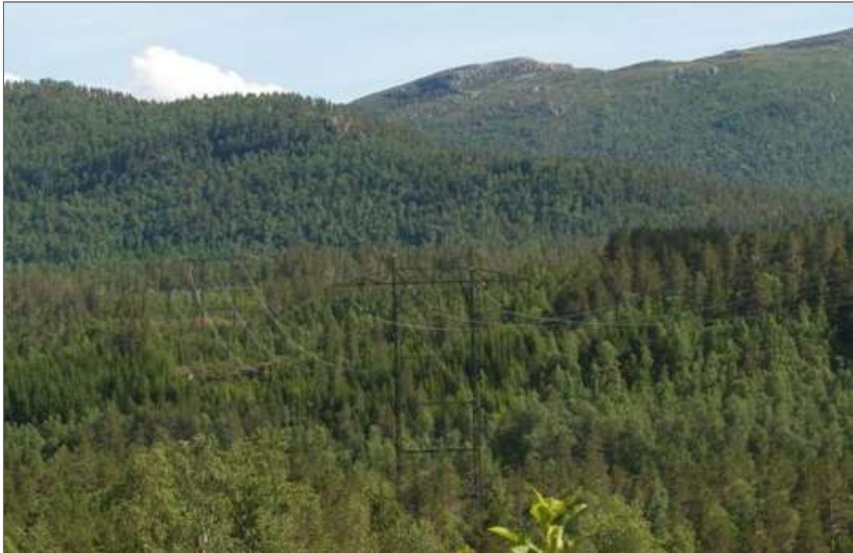
Figur 38: Kamouflert kraftledning med mattede liner og komposittisolatorer stedet for av glass.
