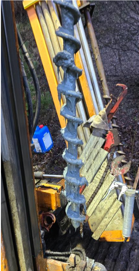
Figur 2-11 Posisjon 2410-10: naver dybde ca 2 m
