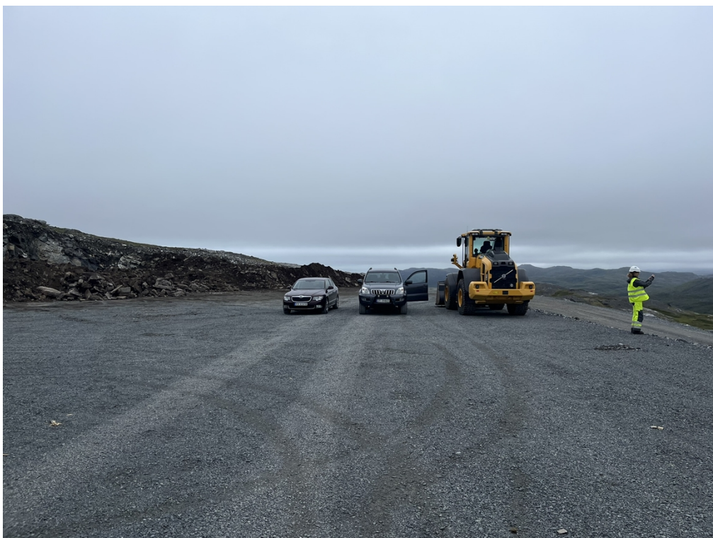
Bilde 5: Sørlike del av lager-/riggplassen med adkomstvegen helt til høyre i bildet. Adkomstvegen ligger lavere i terrenget enn plassen. Foto: NVE.
