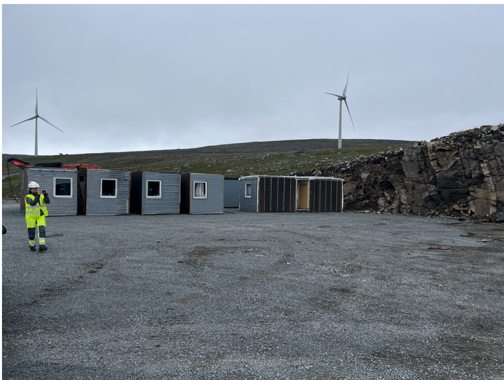
Bilde 3: Noen brakker står igjen på lager-/riggplassen. Disse var i ferd med å fjernes. Bildet viser også deler av den høye skjæringen i bakkant av plassen. Foto: NVE.
