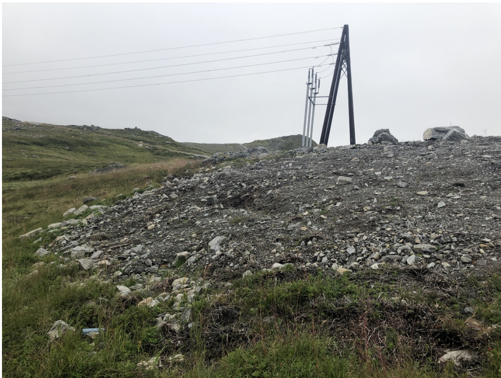
Bilde 16: Arealet på nedsiden av veien er ikke tilfredsstillende istandsatt. Dette området ble også påpekt under inspeksjonen i 2021. Foto: NVE.
