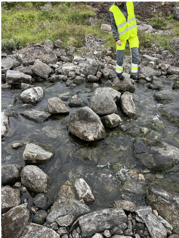
Bilde 8: Punktet i elva hvor utførende har krysset elva for å gjennomføre anleggsarbeider på motsatt side. Istandsettingen av steinene i elva anses som tilfredsstillende. Foto: NVE.
