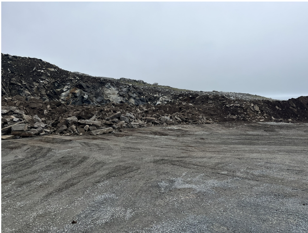
Bilde 4: Entreprenør er i gang med å legge overskuddsmasser fra anlegget ellers på lager-/riggplassen. Disse massene skal brukes til å istandsette plassen. Foto: NVE.
