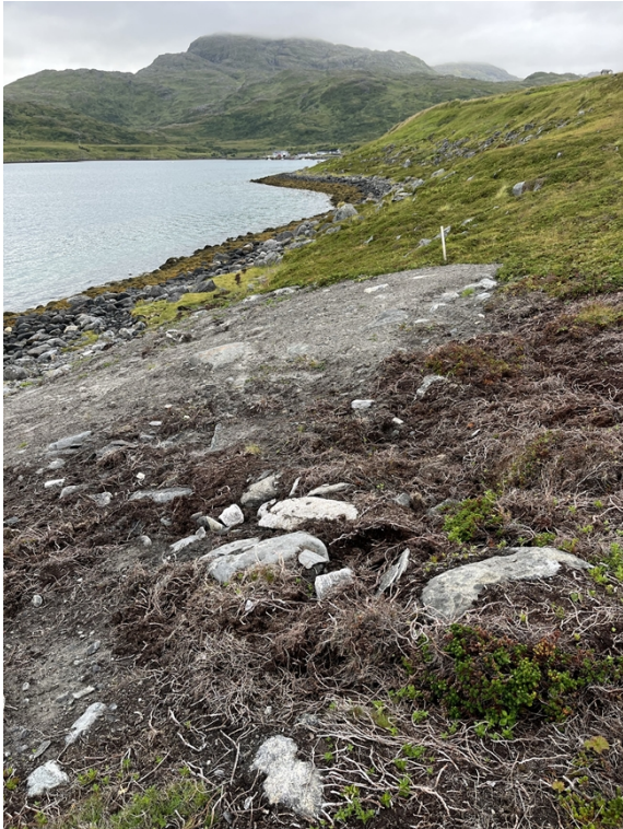
Bilde 9: Område ved ankerpunkt (under baken) hvor det er behov for å tilføre vekstmasser. Trestolpen som er midt i bildet må fjernes. Foto: NVE.
