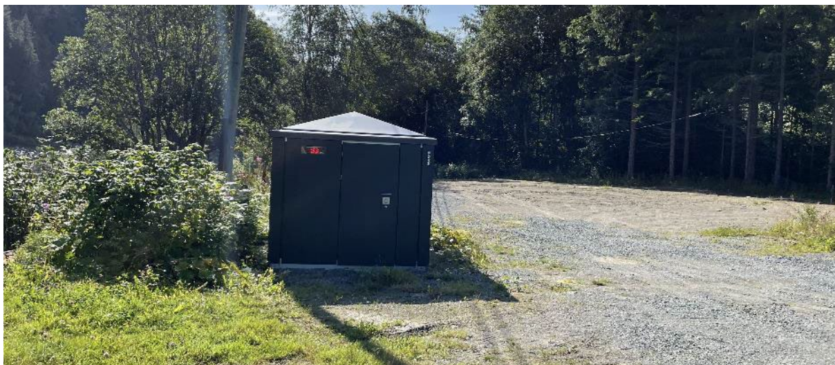
Figur 4-10: Batterirom ved dammen skal integreres i nytt lukehus. Foto: Multiconsult, august 2023
