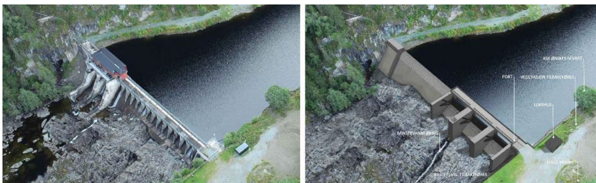
Figur 4-2: Eksisterende dam til venstre og nytt damanlegg høyre, illustrert på dronefoto, av Multiconsult, se vedlegg 2.
