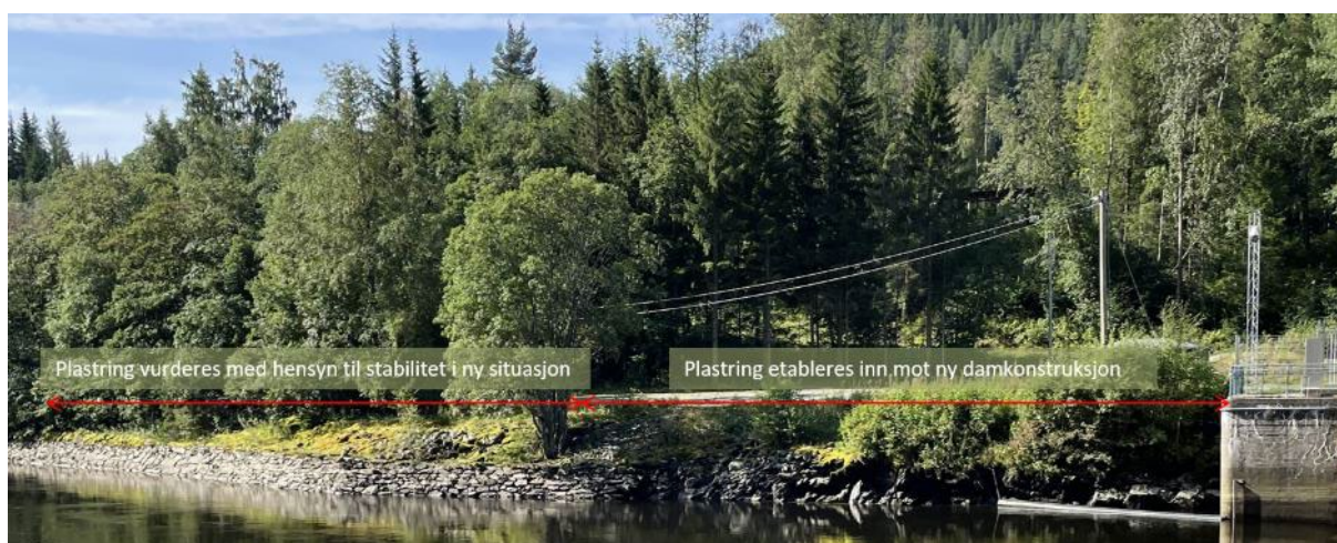
Figur 4-3: Eksisterende plastring på oppstrøms vestsida skal vurderes med hensyn til stabilitet på stedet ved oppstart av anleggsfasen. Der det etableres ny plastring inn mot dammen skal den utformes med samme materialer, helning og uttrykk som i eksisterende plastring. Foto: Multiconsult, august 2023
