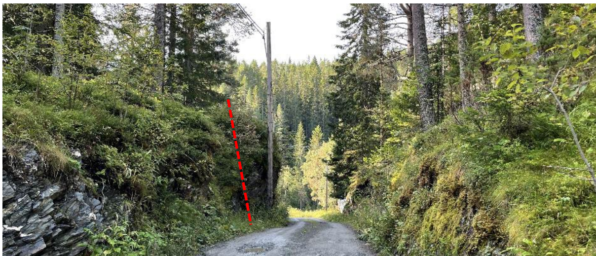
Figur 4-6: Smalt parti med tosidig bergskjæring må pigges og stolpen må flyttes. Det anbefales å kun pigge den sørlig siden av skjæringen, til venstre i bildet. Foto: Multiconsult, august 2023
