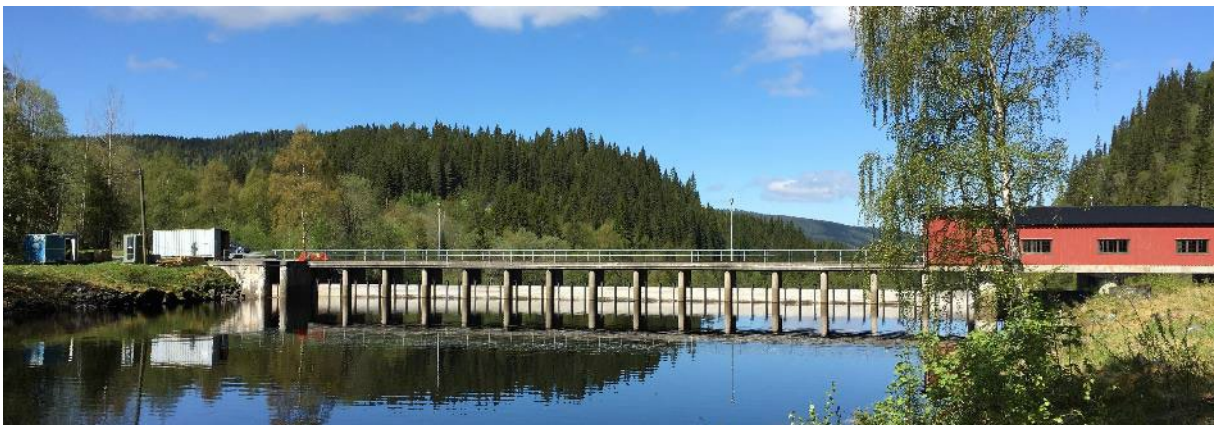
Figur 2-5: Dammen sett fra oppstrøms side (Foto: Multiconsult, 2021).
