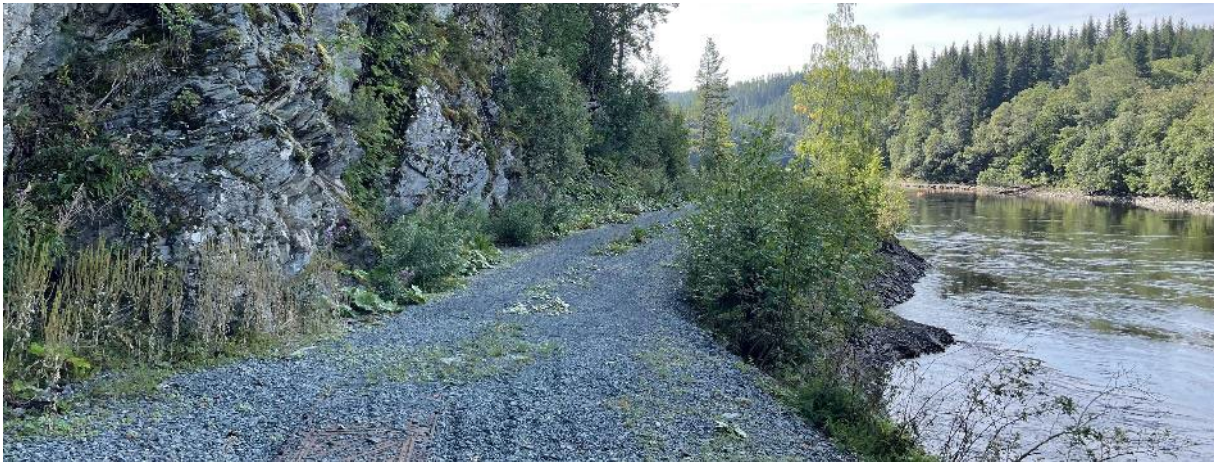
Figur 4-8: Adkomstveg på østsiden av elven benyttes for anleggsadkomst, risiko for steinsprang må hensyntas ved gjennomføring. Foto: Multiconsult, august 2023
