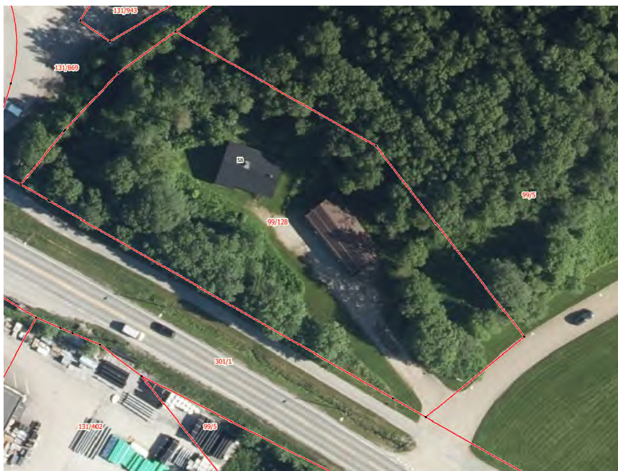
Figur 3: Flyfoto av tomten for ny Ranosen transformatorstasjon, slik den fremstår før utbygging. Kilde: Lineas konsesjonssøknad
