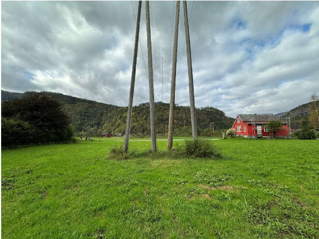
Figur 12. Mast 3 på slåtteteig nede i Granvin. Ett av de husene som ligger relativt nært ledningen, viser til høyre. Granvin transformatorstasjon ligger i bakgrunnen. Foto: Jøsok Prosjekt.
