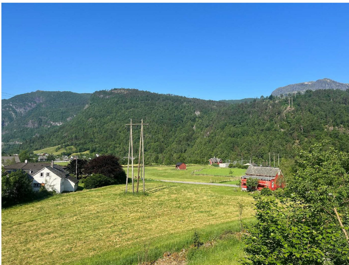
Figur 16. Eksisterende mast på dyrket mark i Granvin. Masten står i samme punkt som mast 3 for ny ledning alternativ 1. Bildet er tatt fra Tveitovegen, og viser to av husene som blir liggende tett inntil kraftledningen. I bakgrunnen skimtes Granvin transformatorstasjon. Foto: BKK.
