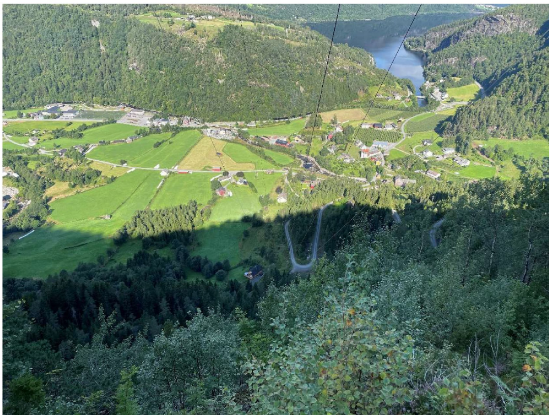
Figur 13. Utsikt i ledningstraseen ned mot Granvin. Granvin transformatorstasjon kan skimtes i bakgrunnen. Foto: BKK.
