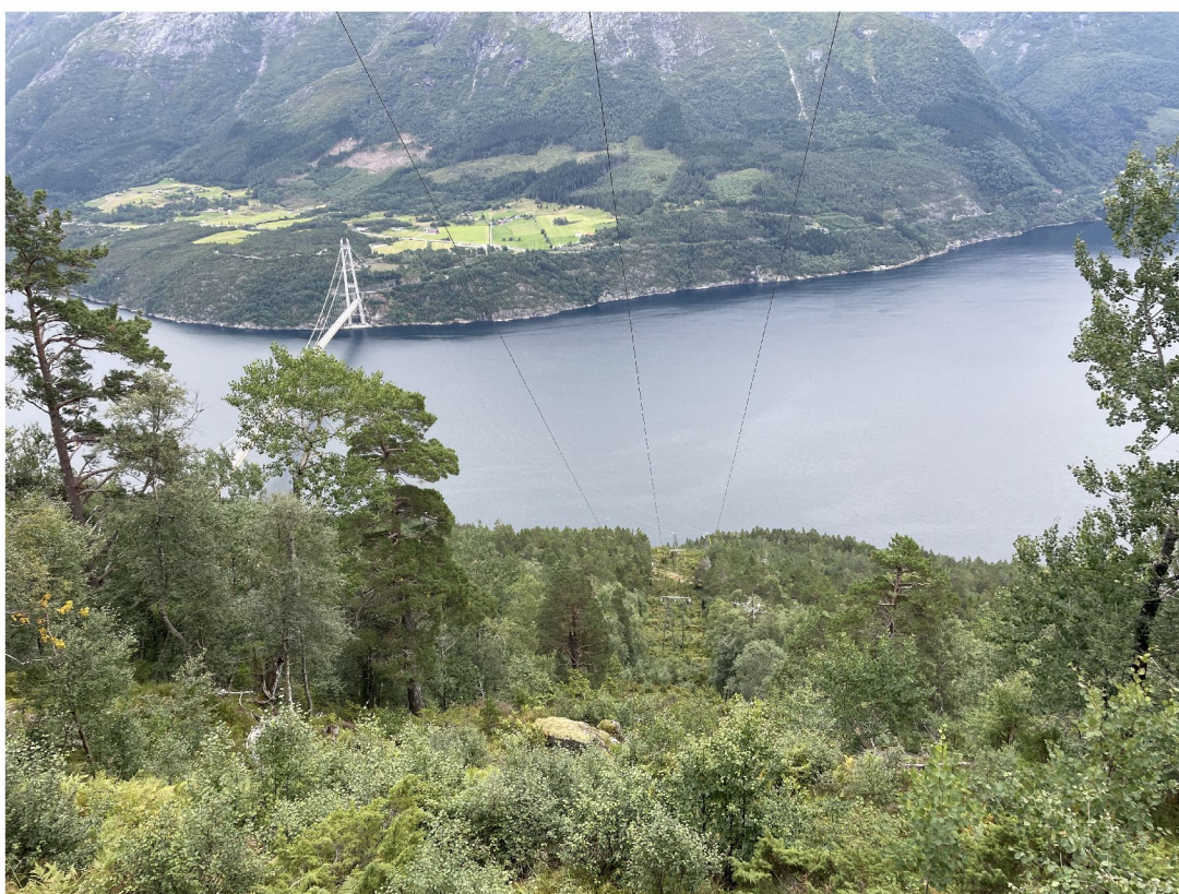
Figur 15. Foto tatt i sørlig retning nedover lien mot Hardangerfjorden. Fjordspennet går på høyre side av Hardangerbrua. Foto: BKK.
