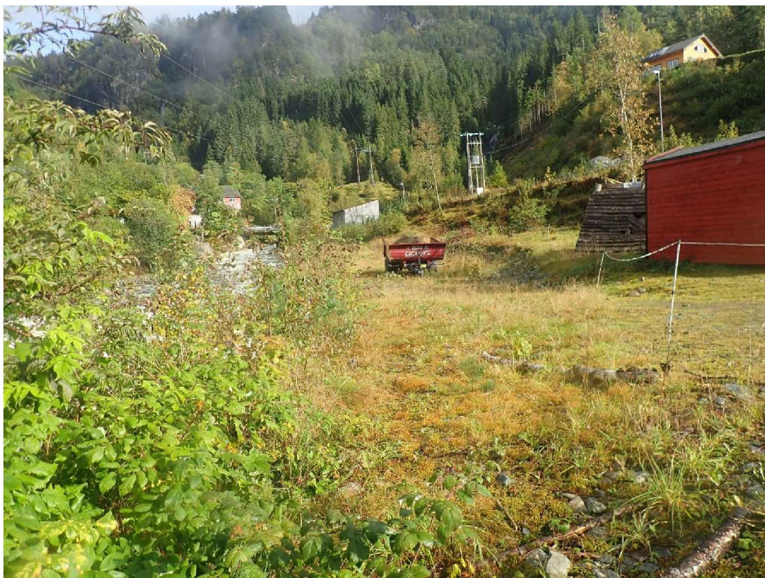
Figur 14. Foto tatt langs trasé-alternativ 2, fra mast 2 og sørøstover mot Risbruhagen. Traseen går mellom de to eksisterende kraftledningene, 132 kV Ulvik – Granvin til venstre og en 22 kV distribusjonsledning tilhørende IHK til høyre. Foto: Jøsok Prosjekt.
