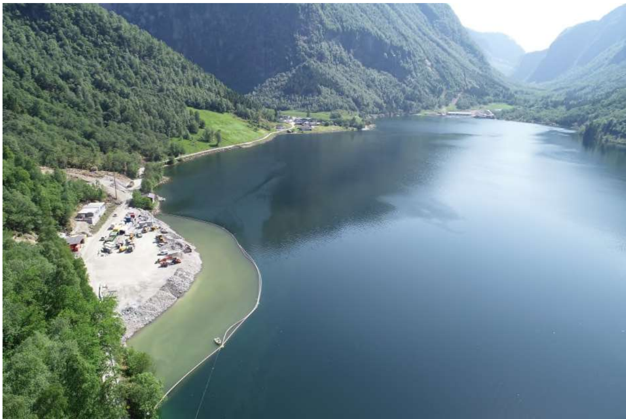
Figur 2. Under anleggsperioden vil ein nytte siltgardin for å redusere spreining av finstoff i sjøen. Her eksempel frå kombinert sjøfylling og utsleppspunkt for tunellvatn ved Østerbø kraftverk (Kjelde: SFE Produksjon AS)
