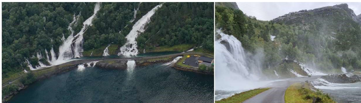
Figur 11. Overløp på Lundavegen ved Åskora næringsbygg
