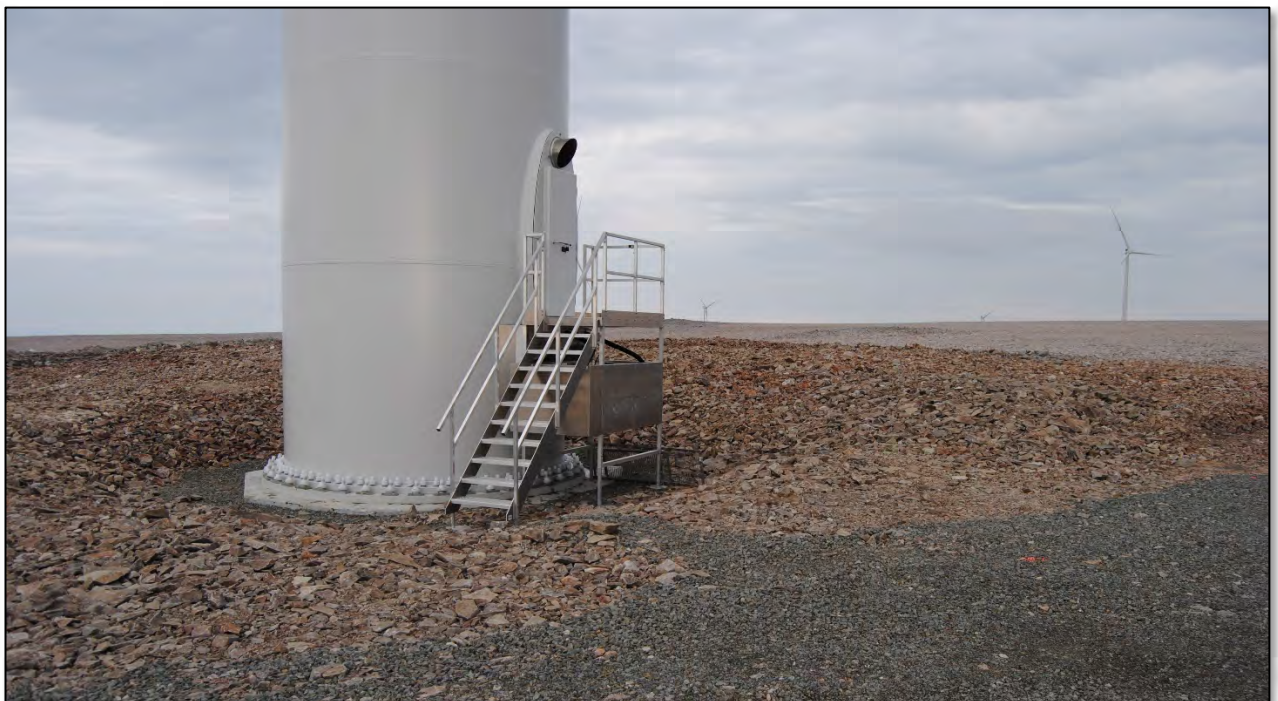
Govus 6-2. Turbiidnafundameantta leiken Raggovidda (Rákkoduoddara) bieggafápmorusttegis (bajábealde) ja fundameanta/toardna manjá go lea devdon mássa fas (vulobealde). Jáhkkmis válljejuvvo seammalágan fundamenteren Davváii. Govven: Multiconsult Norge AS.
