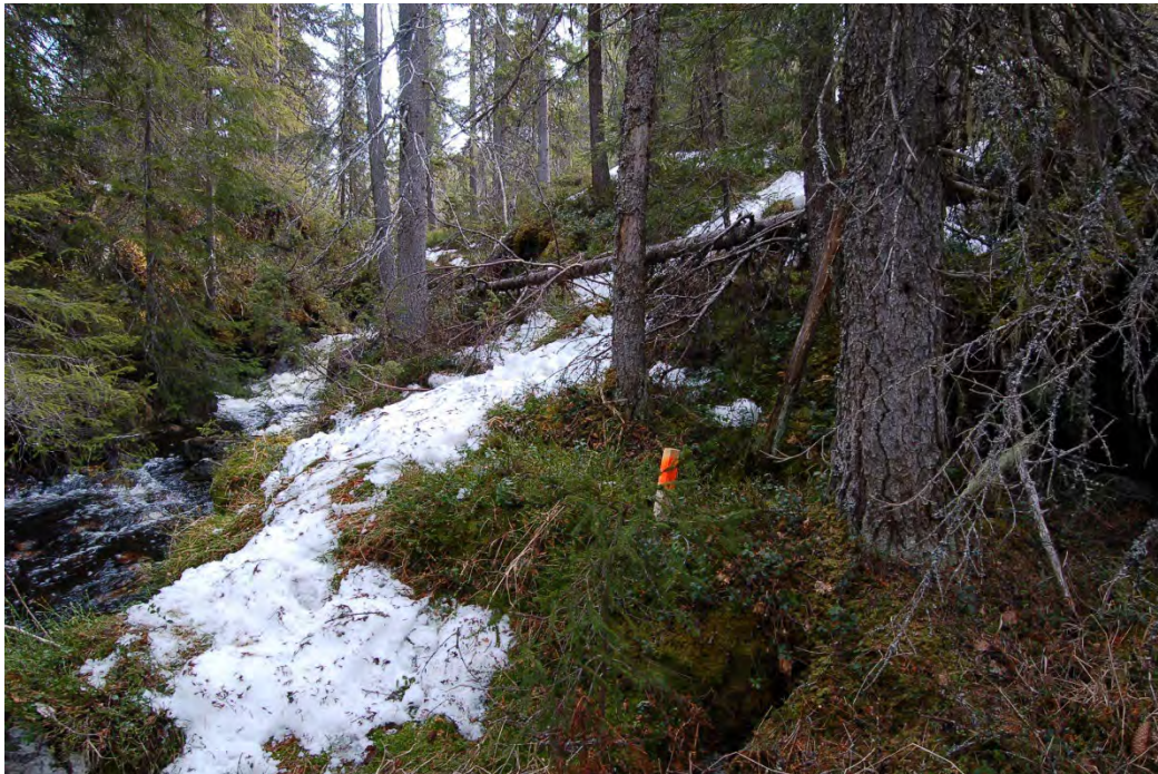
B8, plassering av inntaket er godt skjult med berg i begge vederlagene
