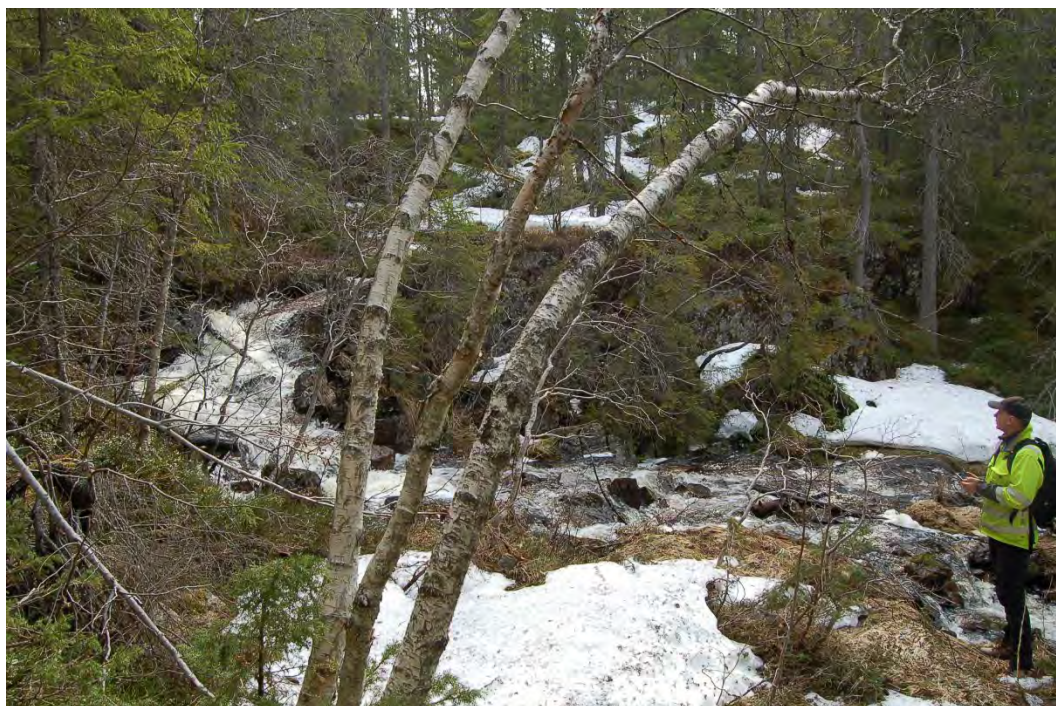
B6, Bjørnstadåi like nedstrøms inntaket, vannveien til venstre i bildet
