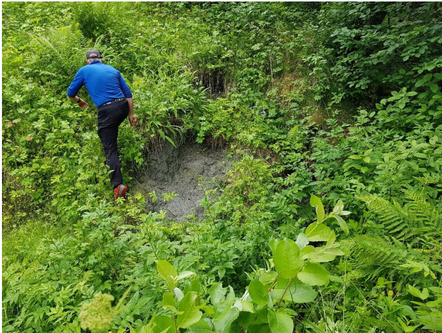
Figur 8: Lit lokal erosjon på strekket mellom bekkene og utløpet.
