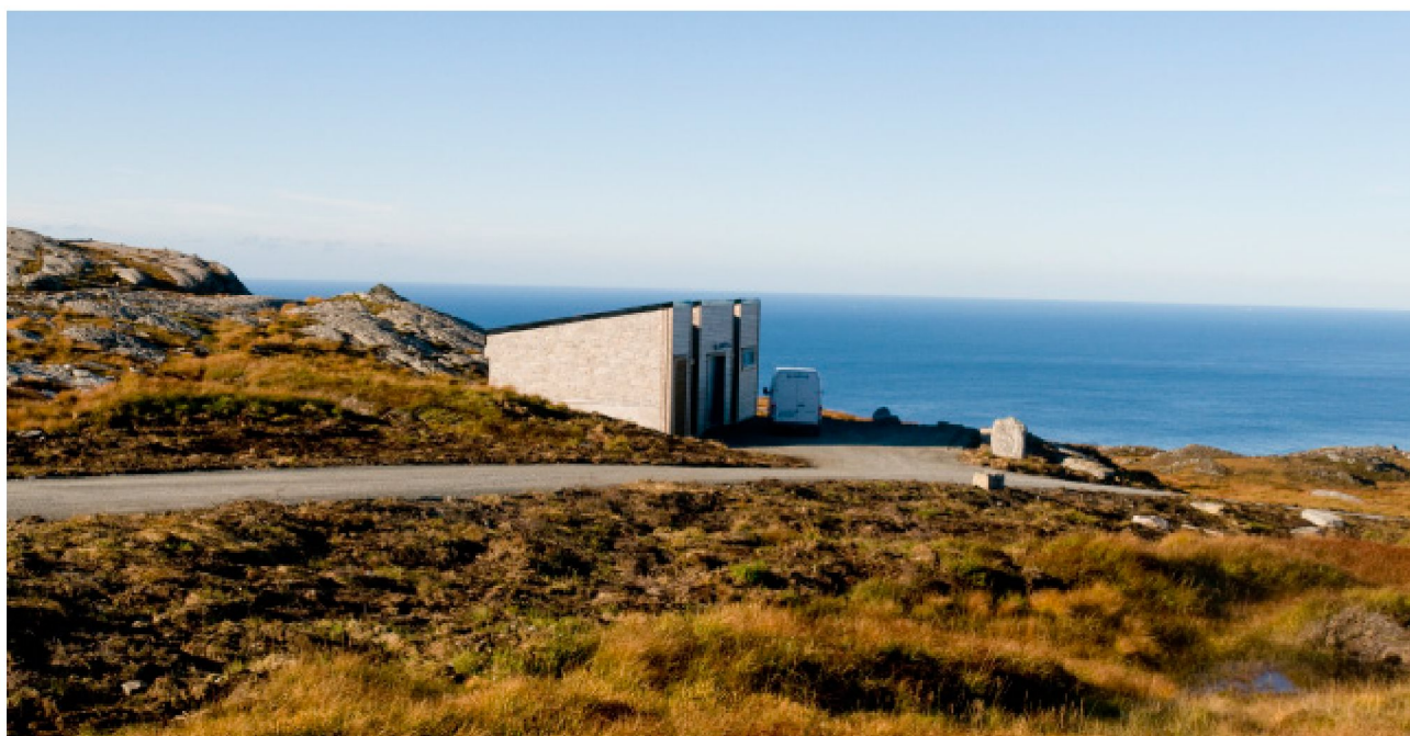
Figur 7-4. Eksempel på koblingsstasjon med servicebygg – Mehuken vindkraftverk. Foto: Einar Berg, Ask Rådgivning.
