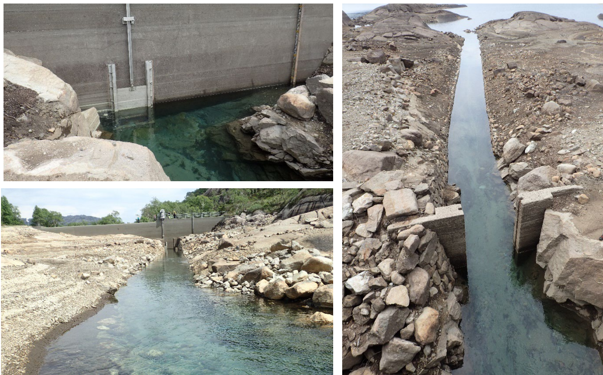
Figur 7. Tappeluke og kanalisering dam Revsvatn
