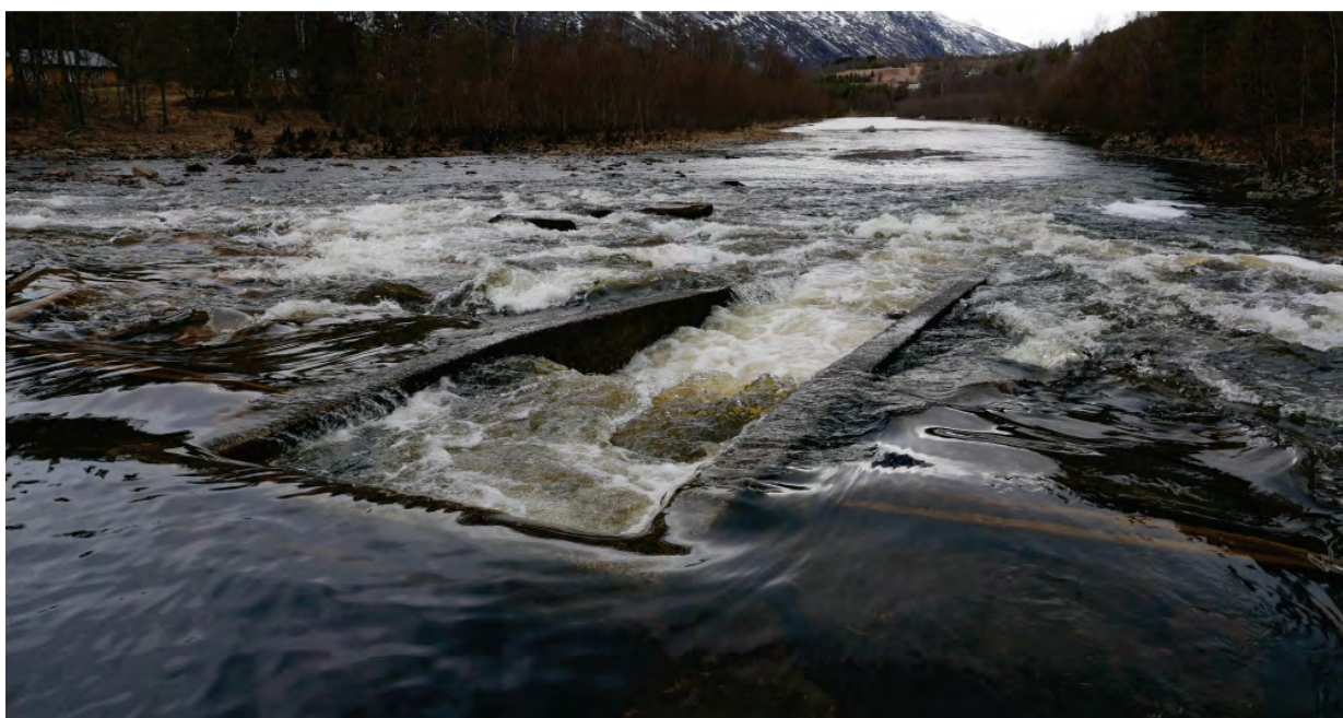
Figur 13: Trappa i Stibergterskelen. Forslag om å snevre inn åpningen med nålestengsel om vinteren for å holde høyere vannstand i øvre delen av terskelbassenget (fra NINA-rapport 1524)
