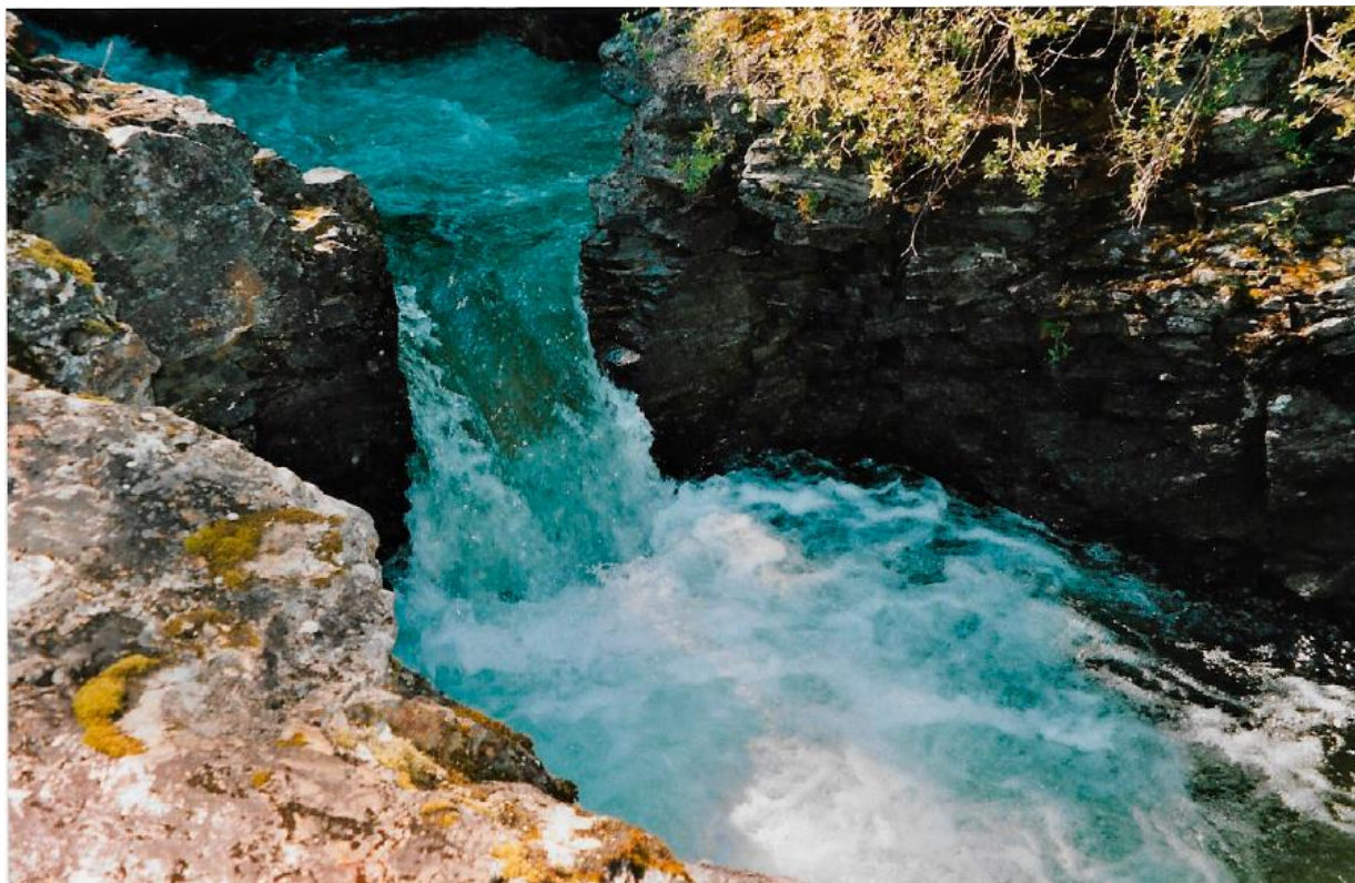
Fig. 53 Typisk trappekul sprengt i berg i trappa i Målselvossen. Foto: Helge Utby.
