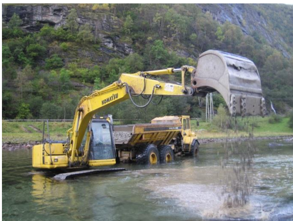
Fig. 14 Utlegging av gytegrus
