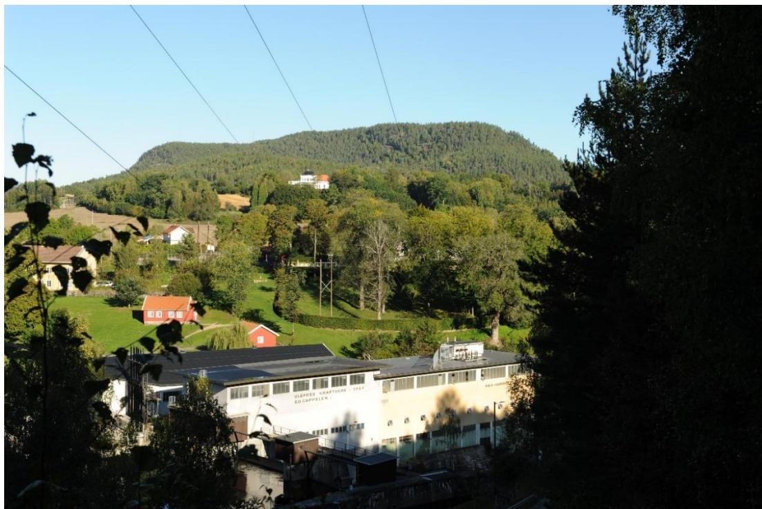
Figur 4-12 Bildet viser førsituasjon ved Ulefoss Kraftverk. I bakgrunnen ser man Ulefos hovedgaard.
