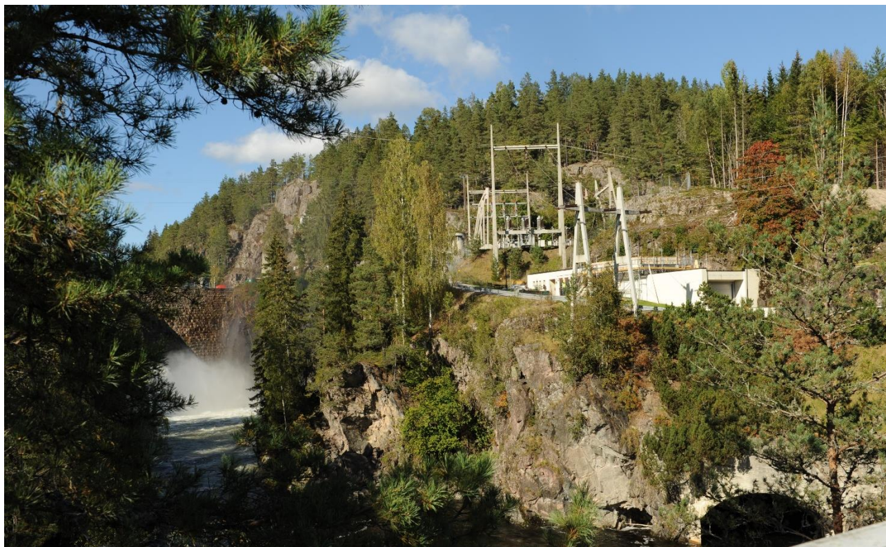
Figur 3-4. Bildet er tatt fra brua ved Vrangfossvegen, og viser Vrangfoss til venstre og Vrangfoss kraftverk til høyre.
