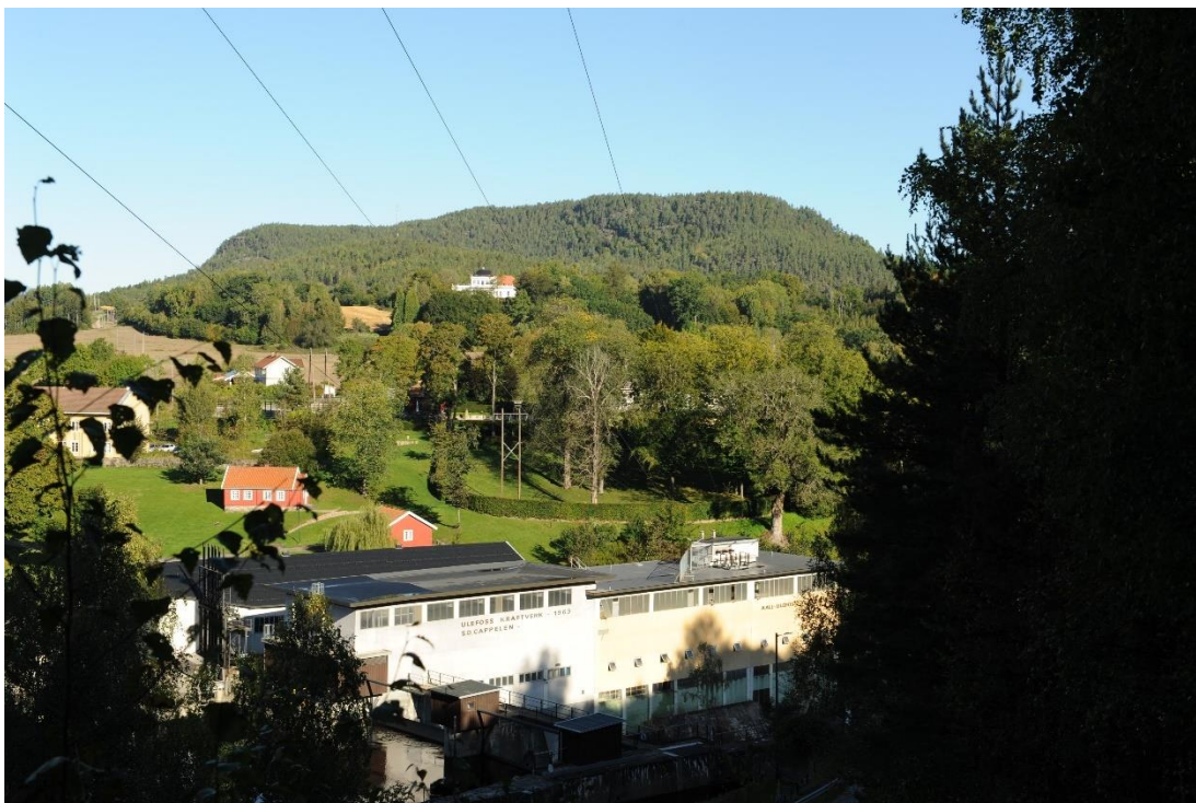
Figur 4-20 Bildet viser dagens situasjon ved Ulefoss kraftverk.
