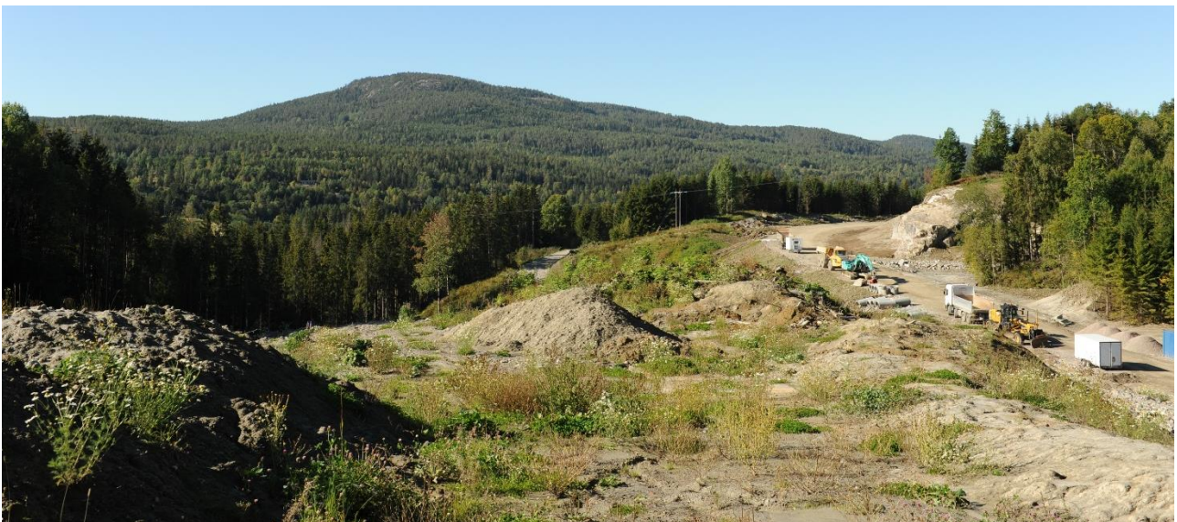
Figur 3-9 Anleggelse av Fv.359.
