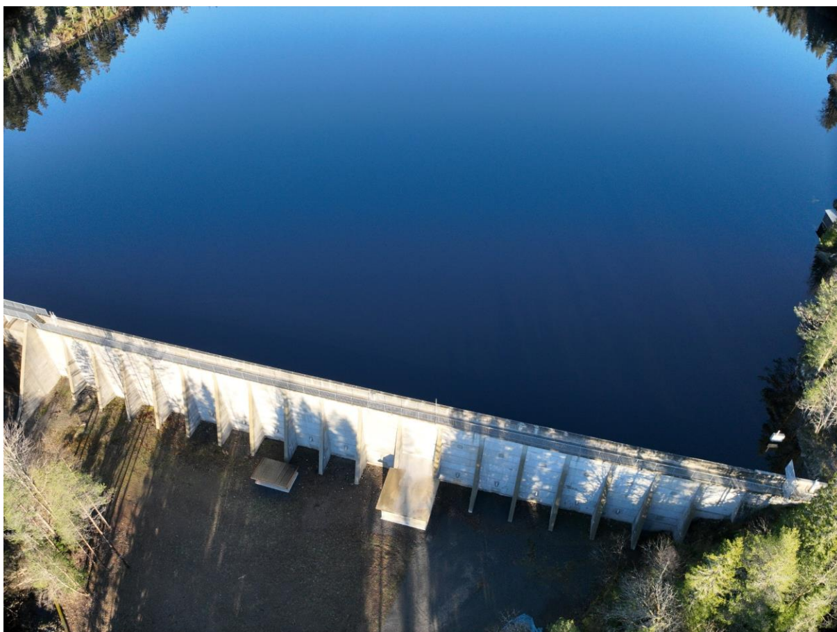
Figur 1-2. Nytt dypvannsinntak vil strekke seg inntil 850 meter inn i dammen. Den gamle dammen ligger neddemt ca. 80 meter nord for dagens dam, til høyre i bildet (Bærum kommune).
