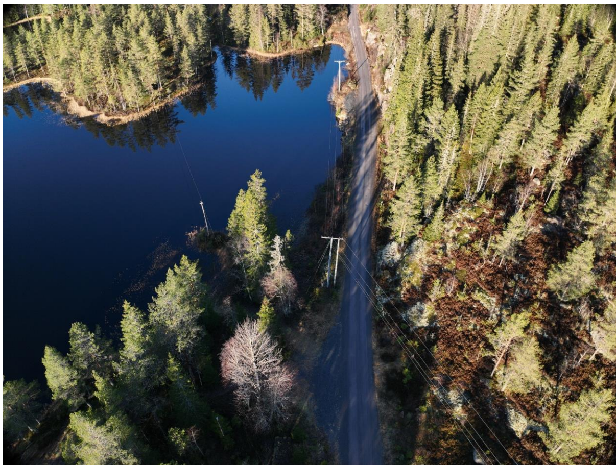
Figur 1-6. Bilde tatt ved pel 580. Bildet viser område for fremføring i grøft gjennom Småvann. Høyspenttrasé krysser over fra østre side av Byveien, mens signaltraséen følger Byveiens vestside over Øvre Småvassmyr (Bærum kommune).
