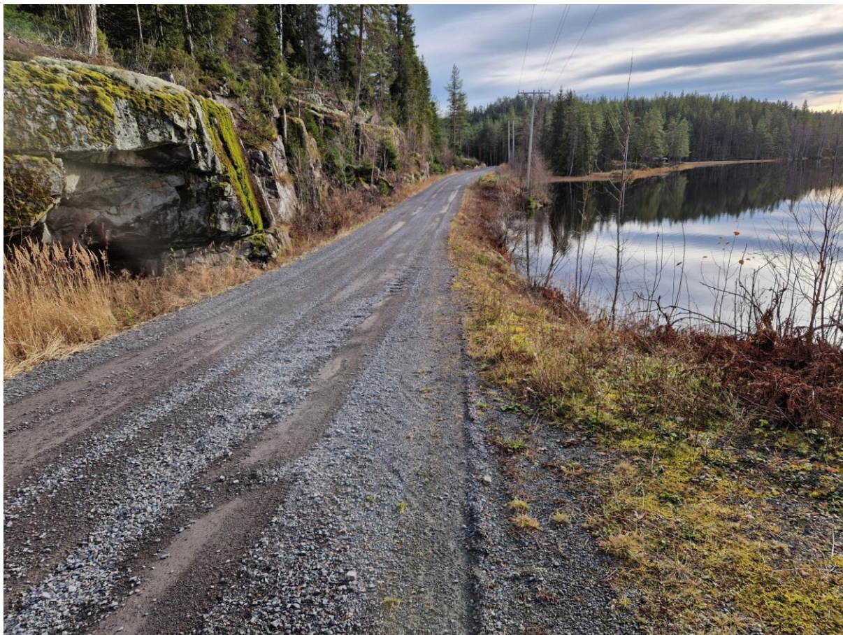
Figur 1-5. Nordøstre bredd av Småvann sett mot syd ved pel 400. Byveien midt i bildet. Ved berghammeren krysser en stikkrenne under veien. Stikkrennen skaper strømmende forhold og åpent vann innerst i vika om vinteren (Rune Bratlie / Multiconsult).
