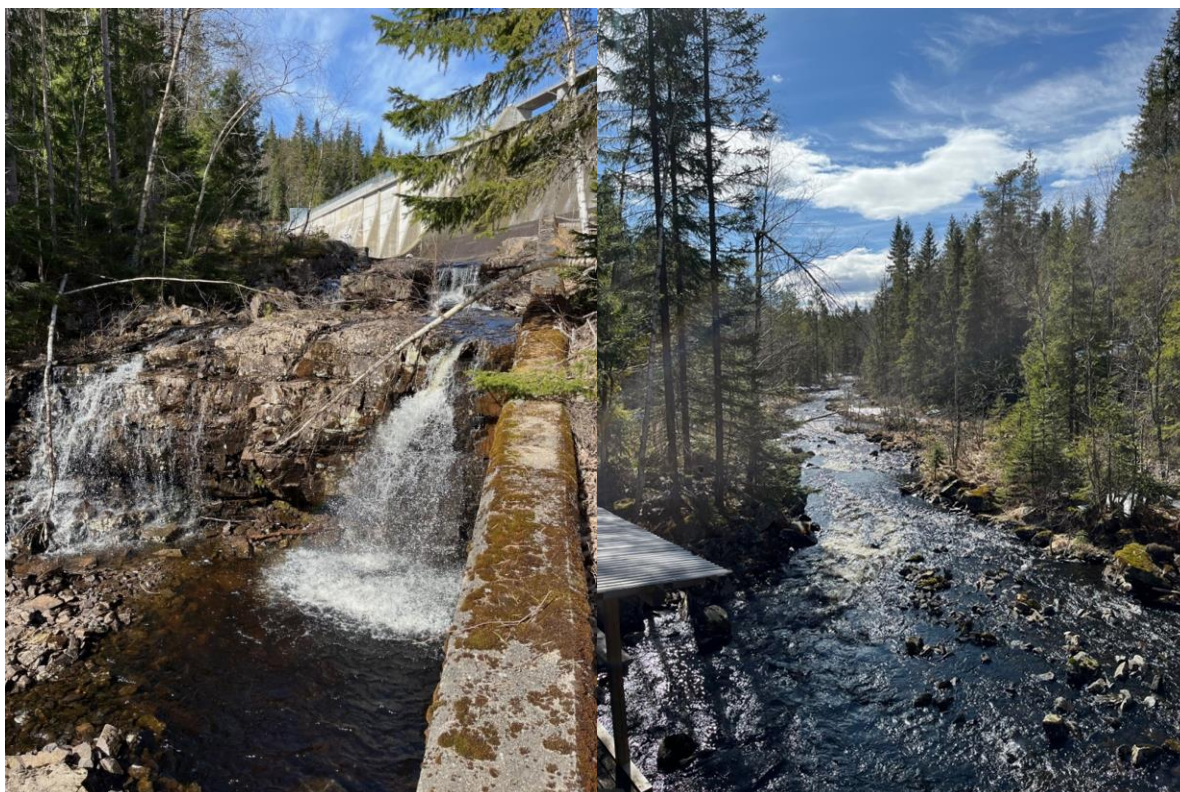
Figur 3-29. Til venstre: Byvannselva rett nedstrøms dammen: utmerket habitat for både fossekall og vintererle. Den lille fossen til venstre eksisterer kun når dammen går i overløp. Lokaliteten er en god kandidat for oppheng av hekkekasse for både vintererle og fossekall. Til høyre: Byvannselva mellom Byvann og Småvann. Bildet er tatt mot sør, like nedstrøms bildet til venstre. (Rune Moe / Multiconsult).
