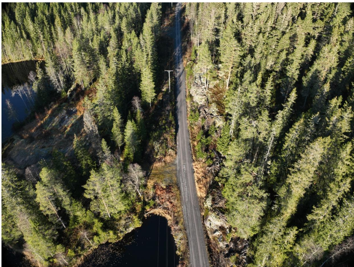
Figur 1-4. Bilde tatt ved pel 450. Byveien strekker seg her gjennom en trang passasje mellom Småvann og fjellskjæringen på veiens østside. Lengst bak vises såvidt avkjøringen til skogsbilveien vestover på nordsiden av Småvann. I framgrunnen vises en avkjøring til den tidligere bebyggelsen i glenna til venstre i bildet (Bærum kommune).
