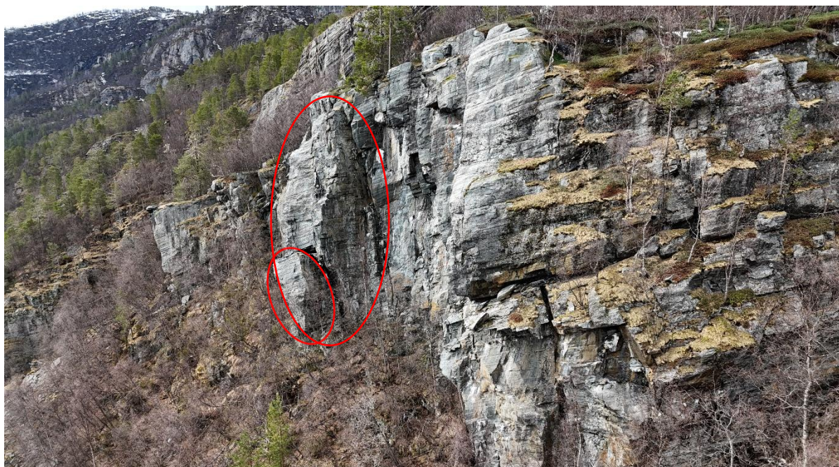
Figur 13: Røde sirkler indikerer observerte delvis avløste større bergparti. Bildet er tatt med drone i sørlig del av påvirkningsområdet, og ser mot sørvest.
